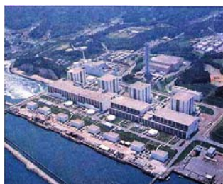
福島第二原子力発電所
