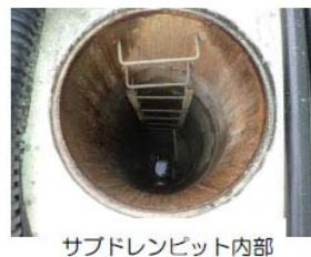
サブドレンピット内部
