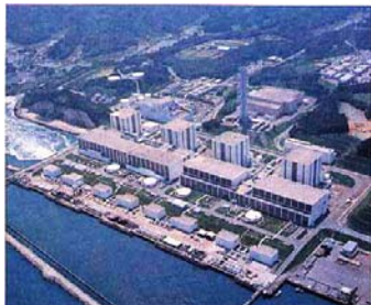
福島第二原子力発電所
