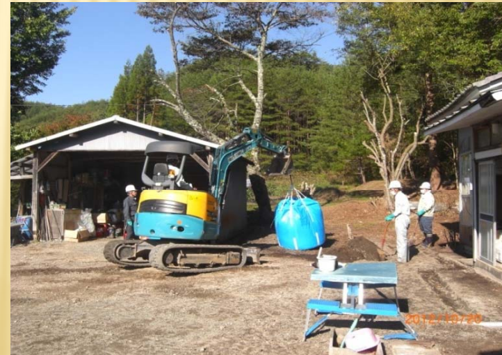
④表土剥ぎ取り作業
