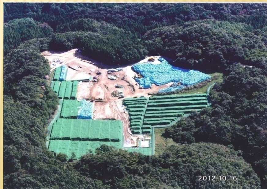
③仮置き場の全景
