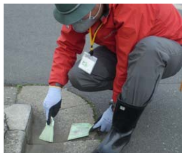
福島市内で除染作業をする参加者
