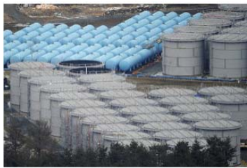
敷地に並ぶ貯水タンク
