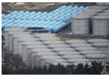
敷地に並ぶ貯水タンク
