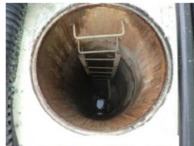
サブドレンピット内部
