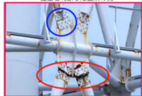
破断及び変形と判断した箇所の例
