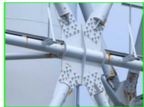
健全と判断した箇所の例
