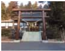
再建された山津見神社拝殿
