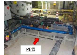
新規PE管施工後
