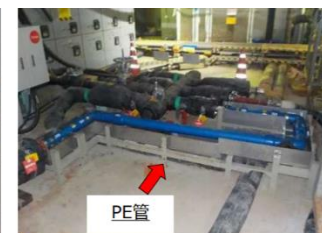
新規PE管施工後
