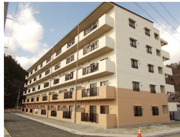
災害公営住宅（岩手県宮古市）
