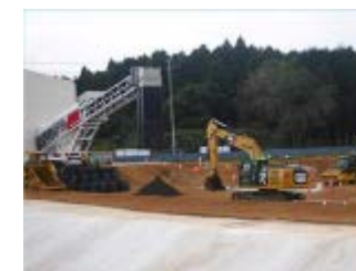
中間貯蔵施設
