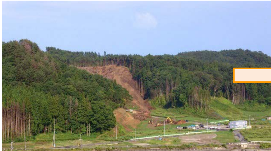
着工時の状況（2013年8月）
