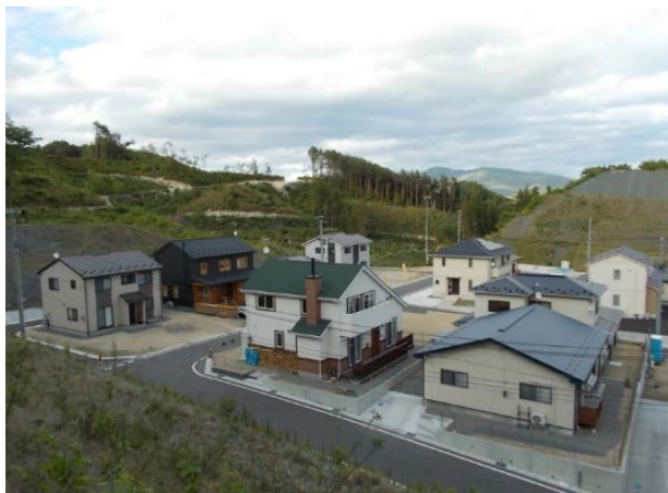
防災集団移転（岩手県宮古市）
