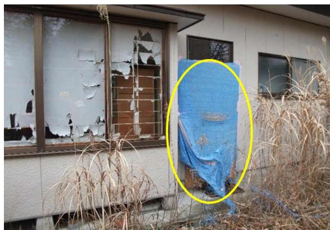
【勝手口から猪突入、ベニヤなどで補修】
