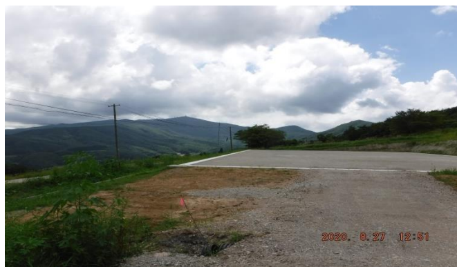
造成工事を終えた川内村ワイナリーの工場用地
