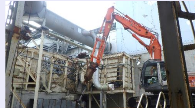
＜ガレキ撤去作業の様子＞
