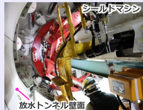
シールドマシン内部で 後方から前方部を撮影 ＜シールドマシン掘進作業の状況＞
