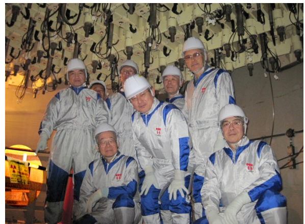
ペDESTAL。3 号機の格納容器内、圧力容器の真下。表示されている線量は 0.34mSv/h
