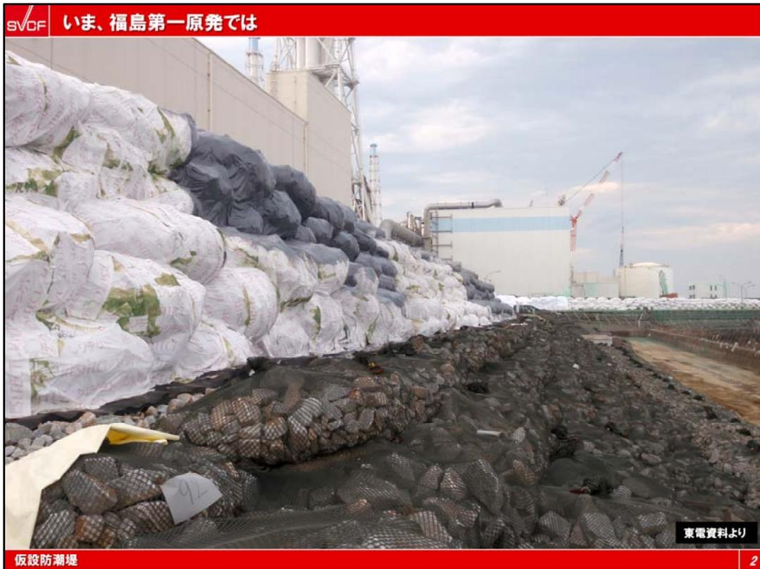
これは、福島第一原発の防潮堤です。本来の防潮堤は昨年の津波で破壊されたため、金網に碎石を詰めたものを、OP10メートルの陸上に5メートルの高さに積み上げたものです。
