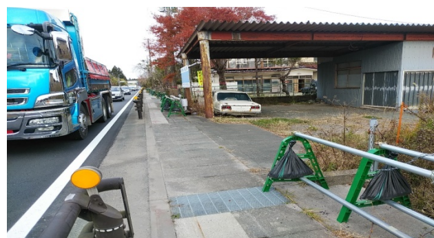
バリケードが除かれた国道6号
