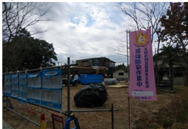
いたるところで解体工事
