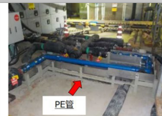
新規PE管施工後
