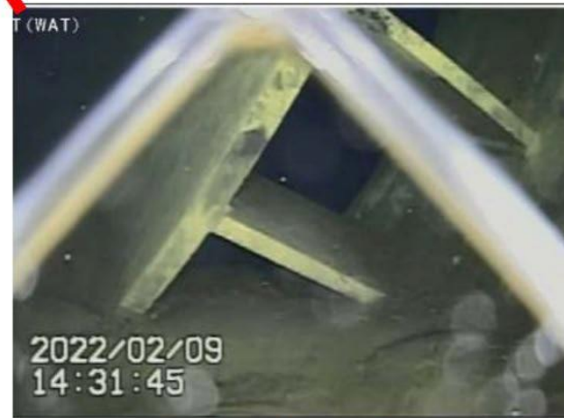
PCV東北東付近の状況（近接）
