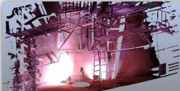
2階シェル壁東面 (点群データ)
