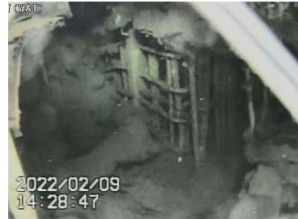
A. ペDESTAL開口部付近
