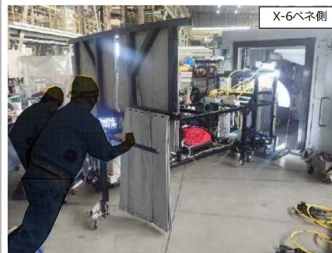
シール機構取付け装置 写真: モックアップ時
