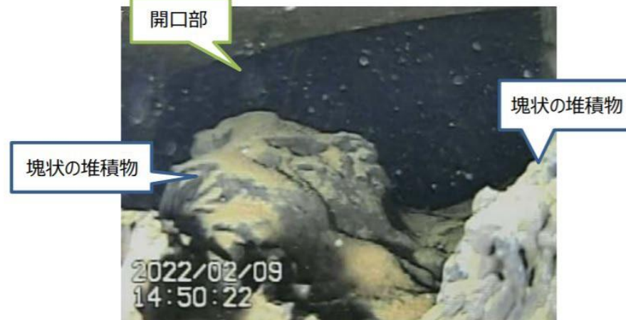
C. ペDESTAL開口部内部
