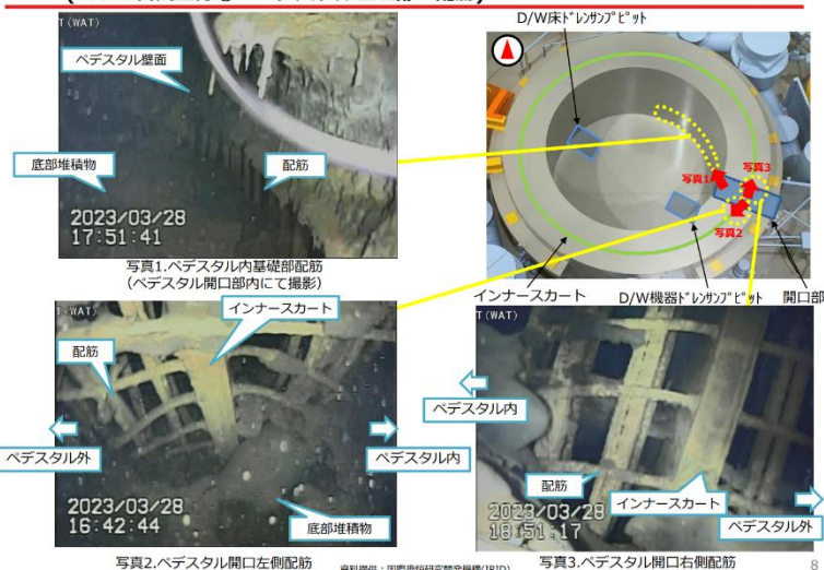
4-1. ペDESTAL外側開口部付近の状況 (3月28日調査分①: ペDESTAL基礎部・配筋)
