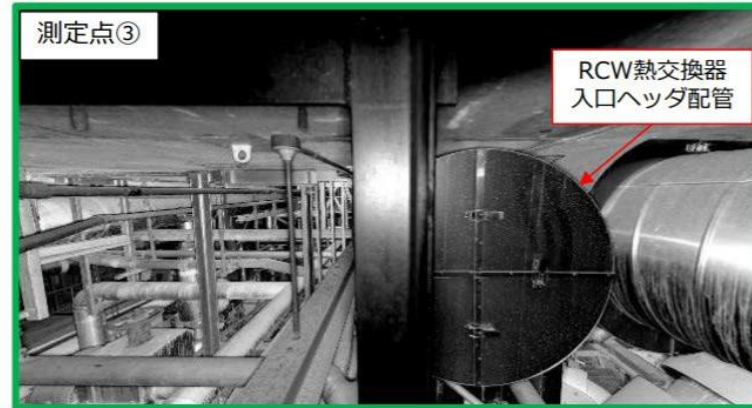
調査用穿孔部(1)から見た入口ヘッダ配管
