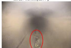
①RCW-Hx(A)(B)側の配管底部の堆積物
