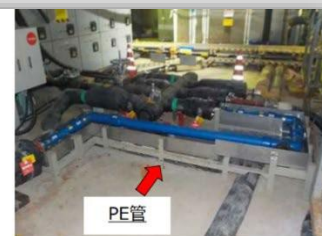
新規PE管施工後
