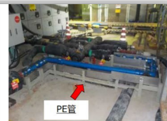
新規PE管施工後
