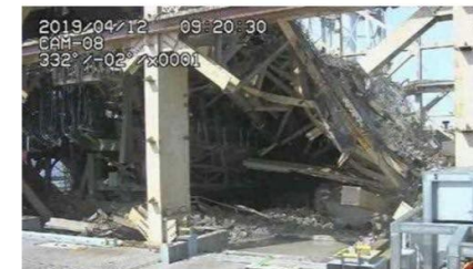
小ガレキ撤去状況
