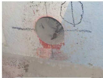
調査用コア採取の状況
