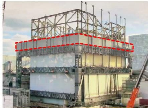
【2017年12月19日：防風フェンス取り付け完了】
