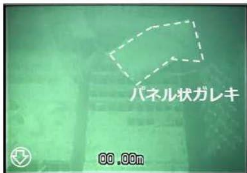
写真① (水中1m 斜め下方向)
