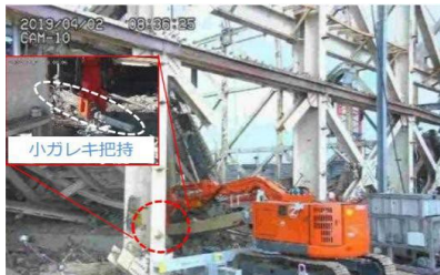
遠隔操作重機による作業状況
