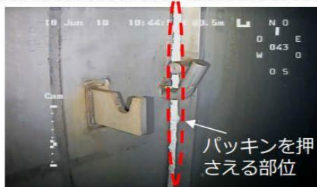
プールゲート支持軸の様子
