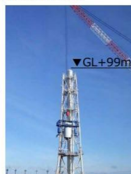
9ブロック解体後 (2020年1月17日)
