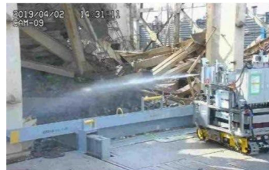
飛散防止剤散布状況
