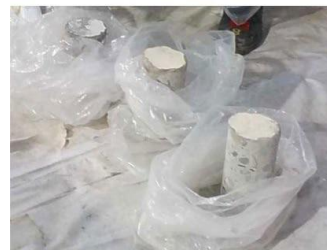
調査用コア採取状況
