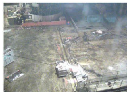
②残置物片付後 (北側) 撮影日(10/22)
