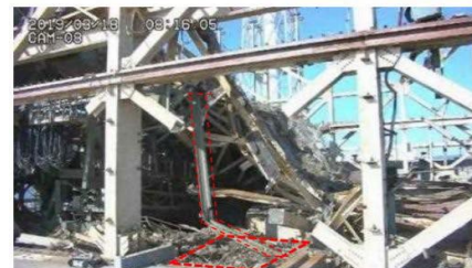
小ガレキ撤去前
