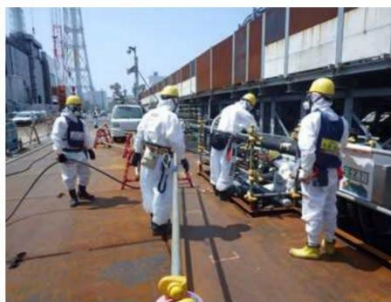
写真③ ケーブル敷設作業状況
