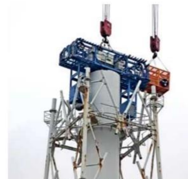
搭乗設備 作業状況
