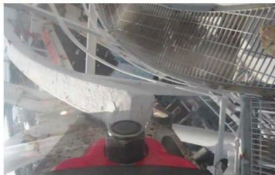
12ブロック目鉄塔解体作業(2月24日)
