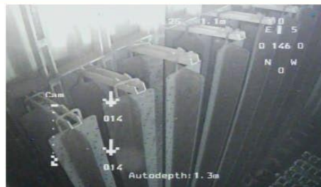
制御棒ハンガー（北東側）の様子
