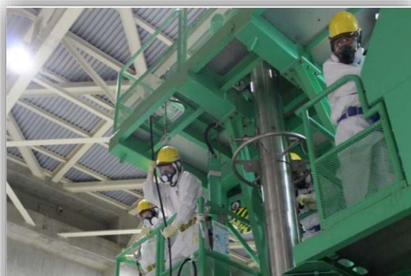
共用プールにおける作業の状況
