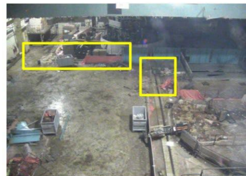
②残置物移動片付後 (北側)
