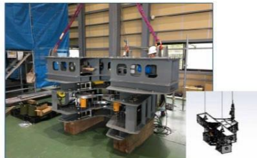
鉄塔解体装置（支柱材用）組立状況
