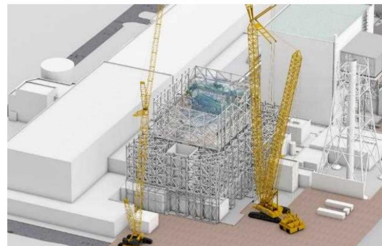
下部架構設置完了
