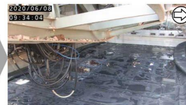
養生バッグ展張 (撮影日: 2020.6.8)
