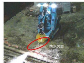
① 散水状況(ダスト抑制対策)
