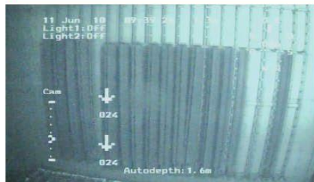
制御棒、制御棒ハンガー全体の様子
