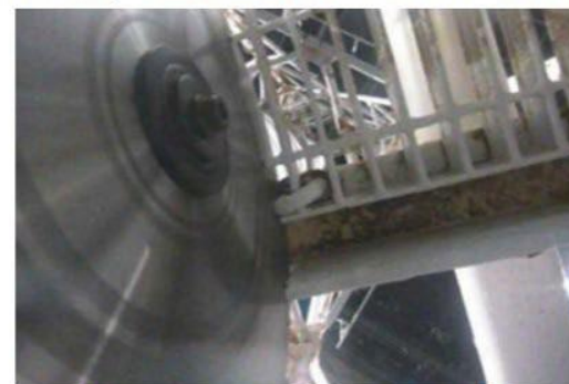
12ブロック目鉄塔解体作業(2月24日)
