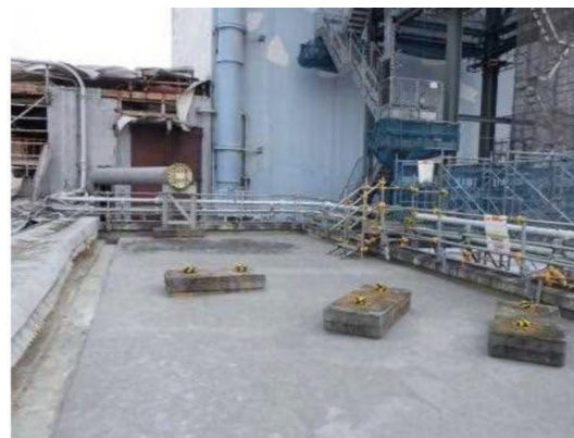
FSTR建屋片付け状況
