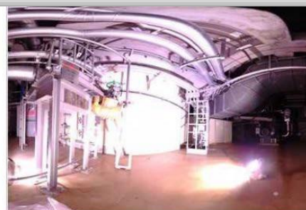
3階シェル壁北東面 (写真)
