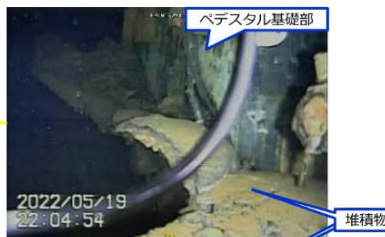
写真1.ペDESTAL開口部(右側基礎部)の堆積物より上部の状況
