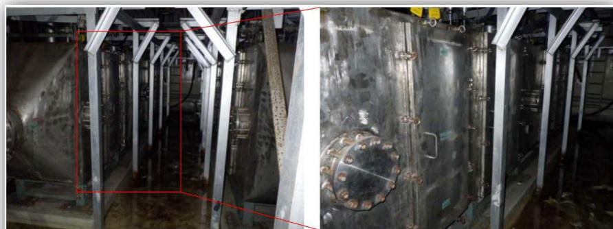
4号機SGTSフィルタレインの様子
