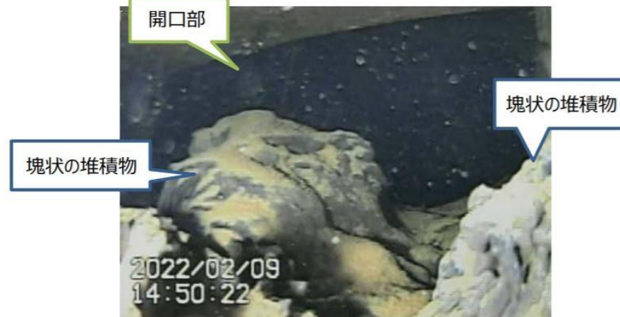
C. ペDESTAL開口部内部
