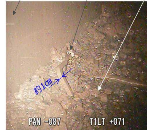
撮影場所C ペDESTAL底部
