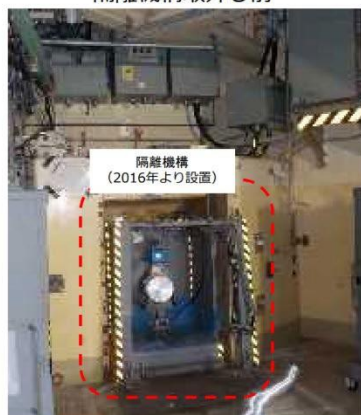
隔離機構取外し前
