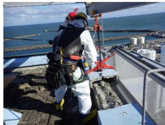
屋上での桁木撤去状況
