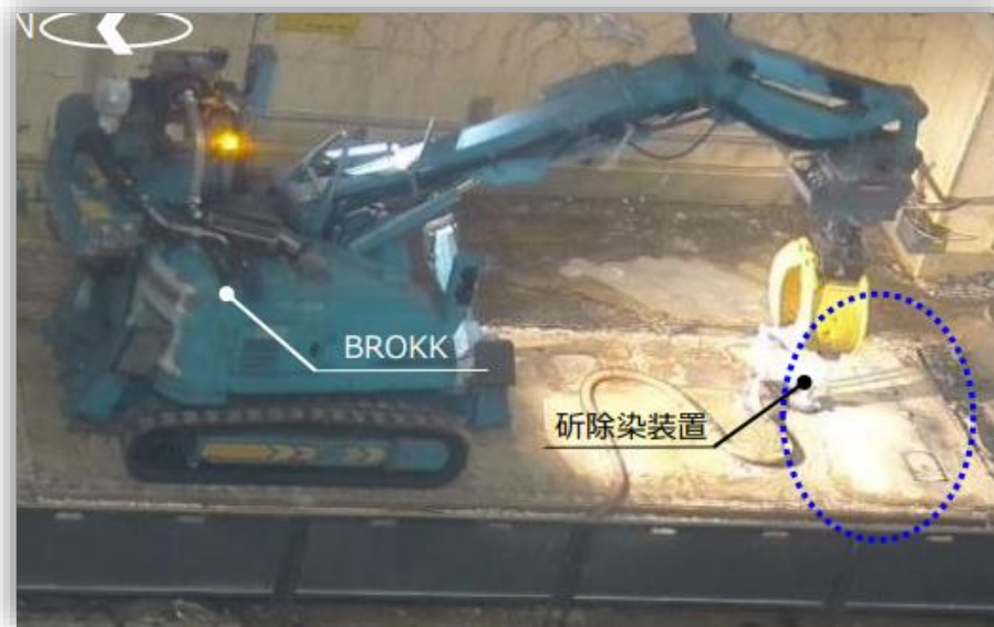
(オペフロ床面の研り除染の状況)
