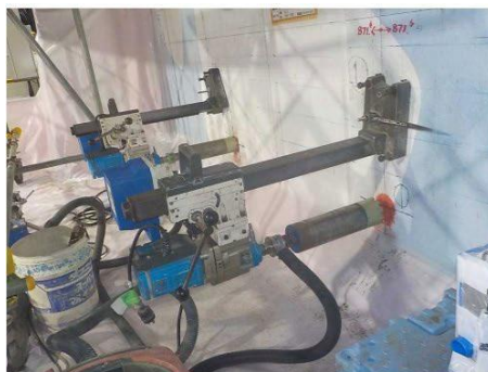
コア削孔装置設置状況
