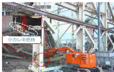
遠隔操作重機による作業状況
