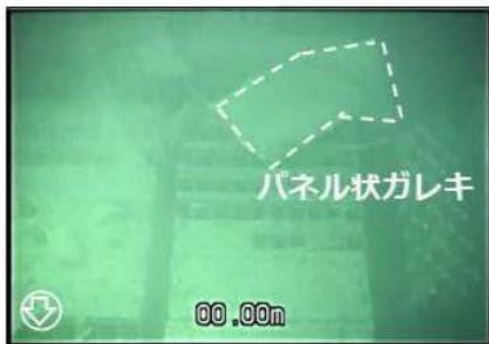
写真① (水中1m 斜め下方向)
