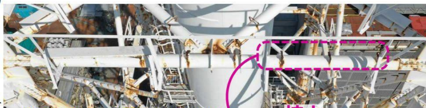
【写真①】 地上約76mの南側水平材
