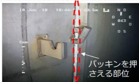
プールゲート支持軸の様子
