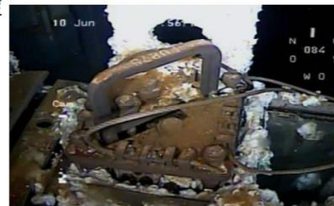
ワイヤー修復燃料上部の様子
