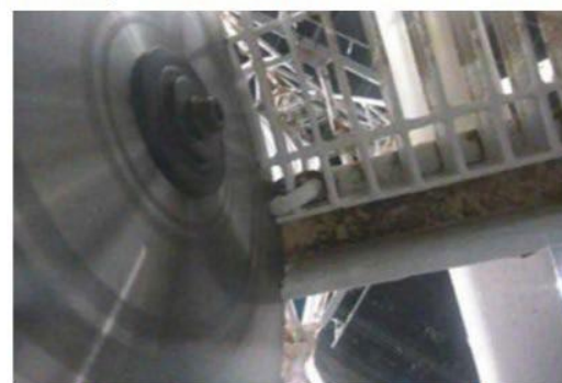
12ブロック目鉄塔解体作業(2月24日)
