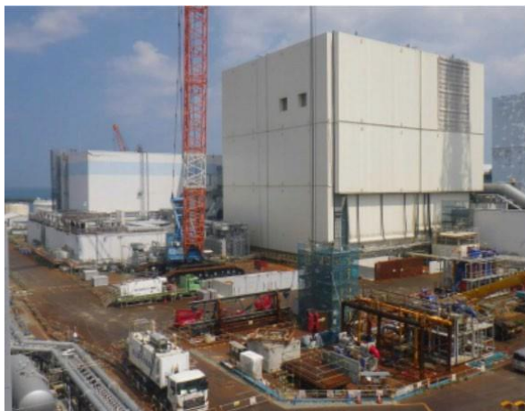
作業開始前の状況写真(2016年7月11日撮影)
