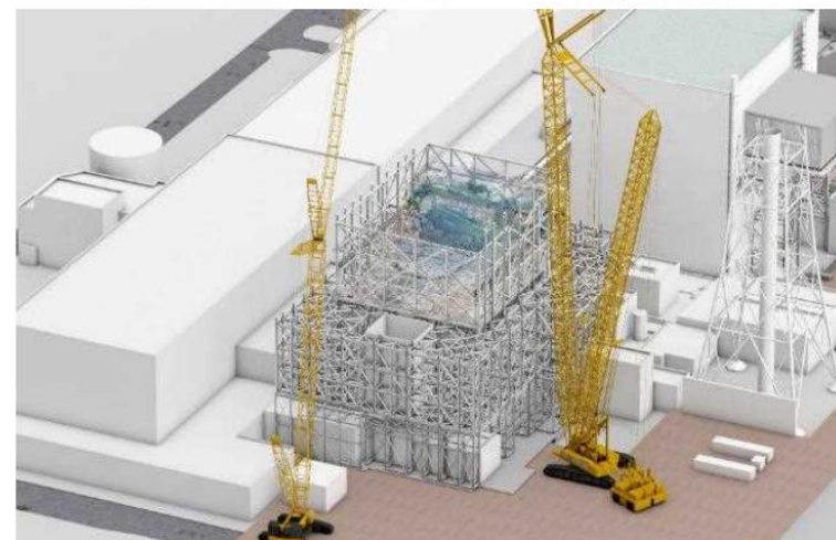
下部架構設置完了
