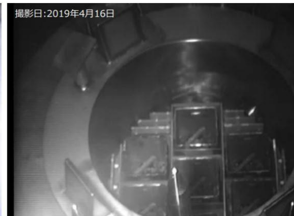
輸送容器へ燃料装填完了(7体)
