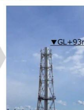
11ブロック解体後 (2020年2月4日)
