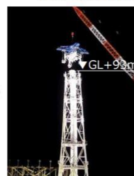
11ブロック解体時 (2020年2月1日)
