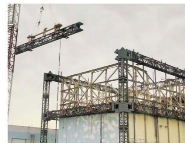
上部解体時の梁取り外し状況 撮影：2017.7
