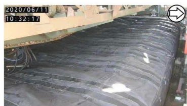
エアモルタル充填 (撮影日: 2020.6.11)
