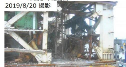
南側小ガレキ撤去後
