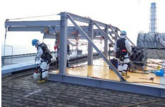
架台設置状況（原子炉建屋屋上）
