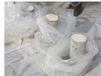
調査用コア採取状況
