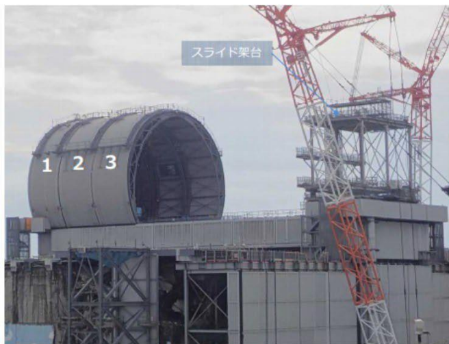
ドーム屋根設置状況 (撮影日:2017年10月17日)
