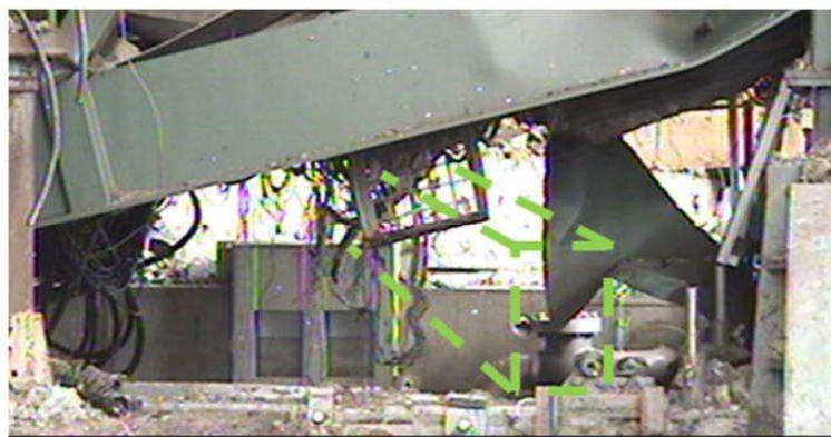
支障物撤去前写真 2020年3月9日撮影
