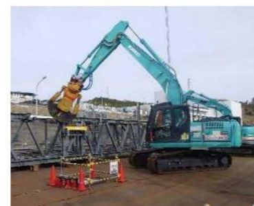
上部解体時の小割解体状況 撮影：2017.4
