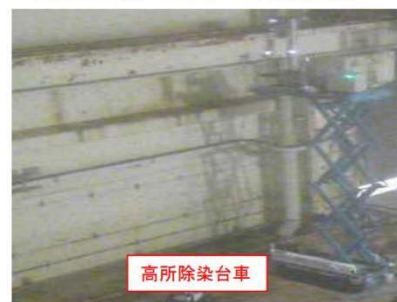
⑤高所空間／表面線量率測定状況
