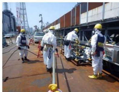
写真③ ケーブル敷設作業状況
