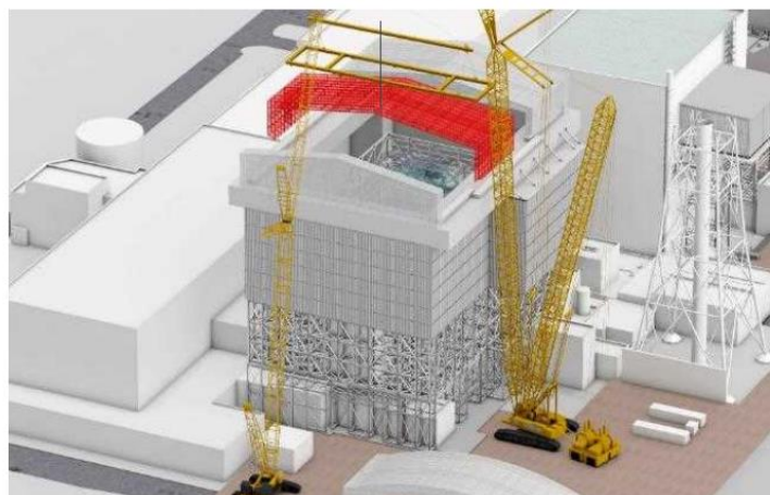
可動屋根設置中
