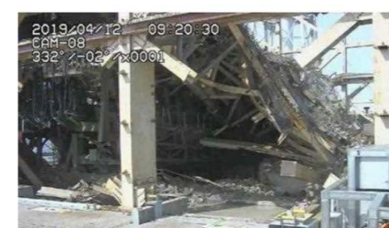
小ガレキ撤去状況
