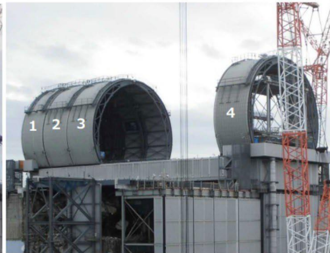
ドーム屋根設置状況 (撮影日:2017年10月25日)
