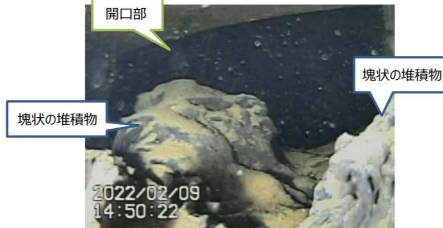
C. ペDESTAL開口部内部
