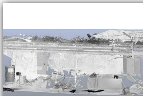
3階シェル壁北面 (点群データ)
