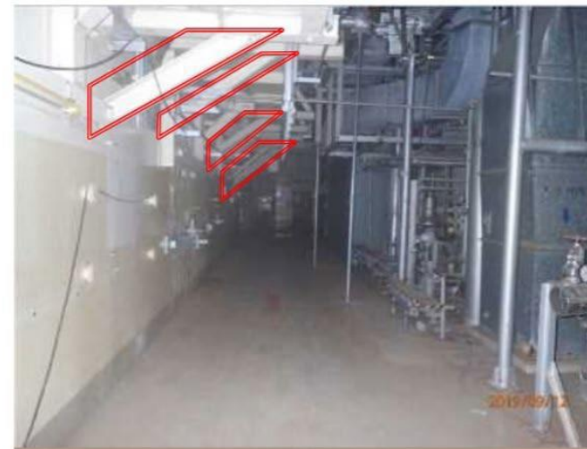
赤枠：対象機器 2号機原子炉建屋1階（西側）
