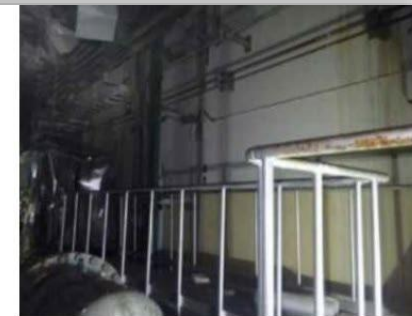
4階プール壁西面 (写真)
