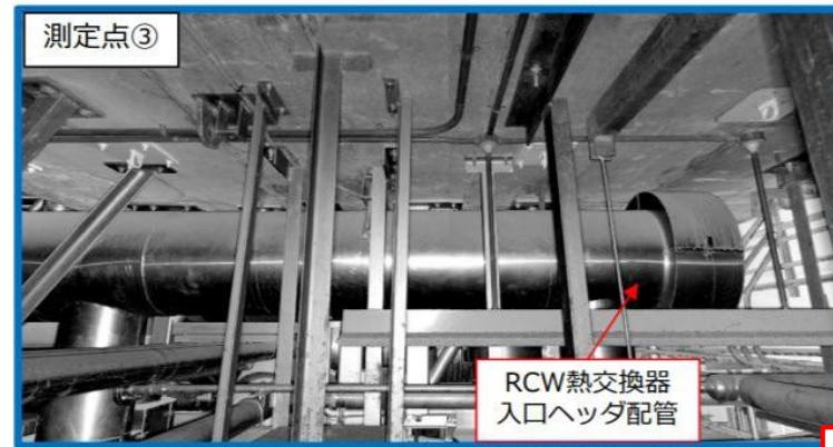
調査用穿孔部(2)から見た入口ヘッダ配管
