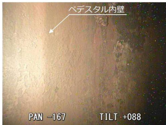
撮影場所D ペDESTAL内壁面
