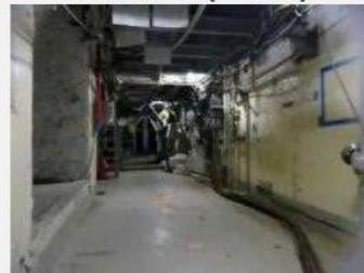
【撤去後】(矢視C)
