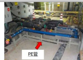
新規PE管施工後
