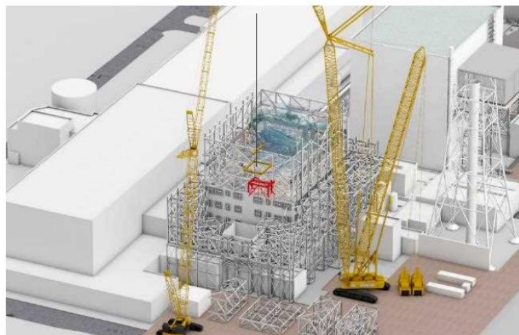
下部架構設置中
