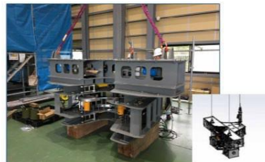
鉄塔解体装置（支柱材用）組立状況
