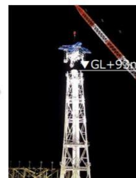
11ブロック解体時 (2020年2月1日)
