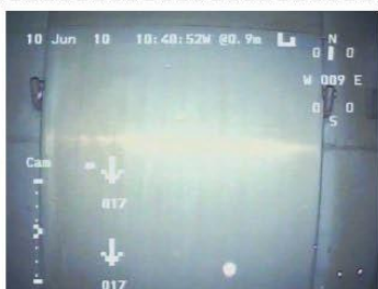
プールゲート正面の様子
