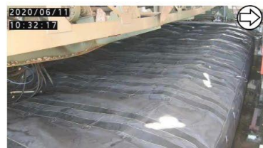
エアモルタル充填 (撮影日: 2020.6.11)
