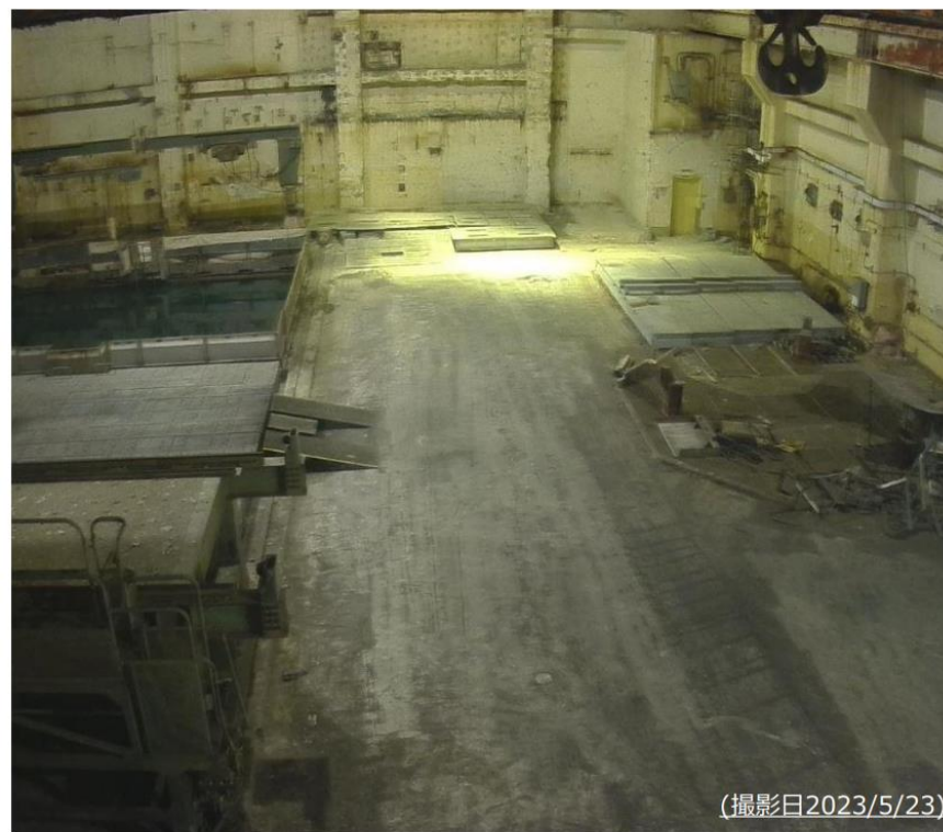
作業進捗状況
