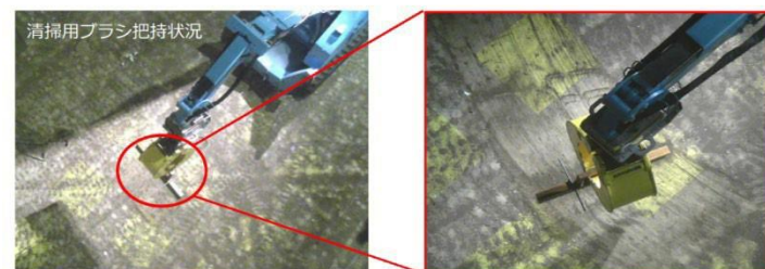
清掃用ブラシを用いて、床面の遊離性ダスト (砂等) を集め、集塵機で回収を行う。
