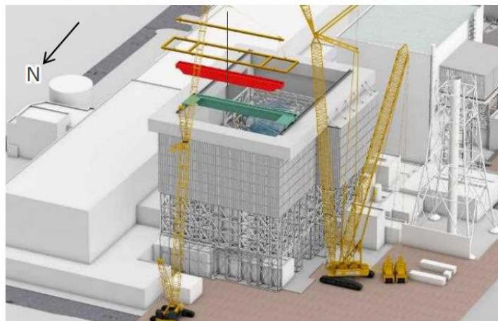
ガレキ撤去用天井クレーン設置中
