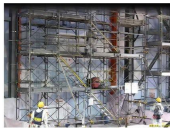
調査用コア採取の作業状況(全景)
