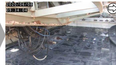
養生バッグ展張 (撮影日: 2020.6.8)
