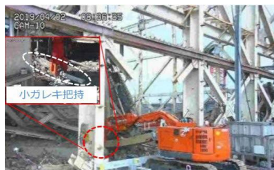
遠隔操作重機による作業状況
