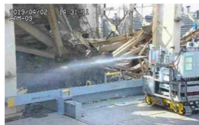
飛散防止剤散布状況
