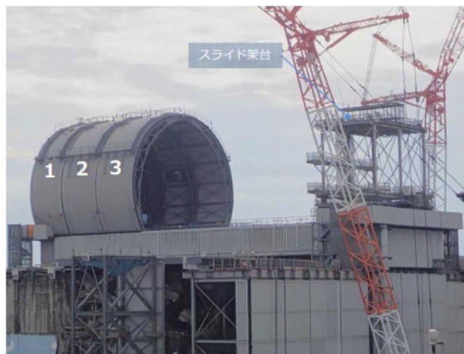
ドーム屋根設置状況 (撮影日:2017年10月17日)
