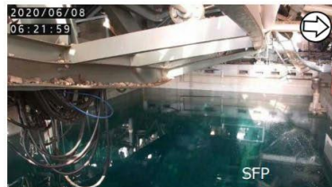
養生バッグ投入前 (撮影日: 2020.6.8)
