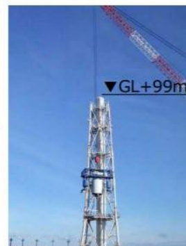
9ブロック解体後 (2020年1月17日)
