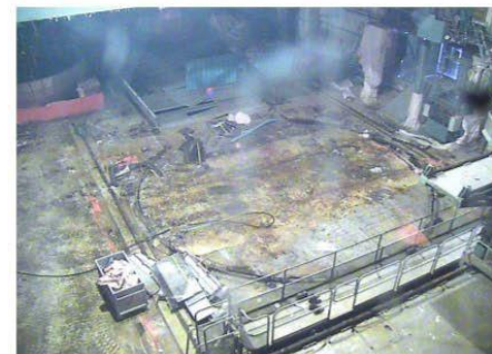
①残置物片付後（ウエル上）撮影日(10/22)
