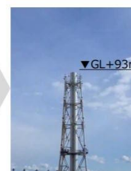
11ブロック解体後 (2020年2月4日)
