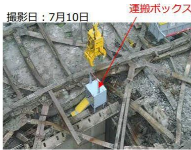
写真① 運搬ボックス設置状況
