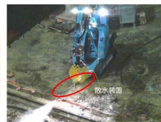
① 散水状況 (ダスト抑制対策)
