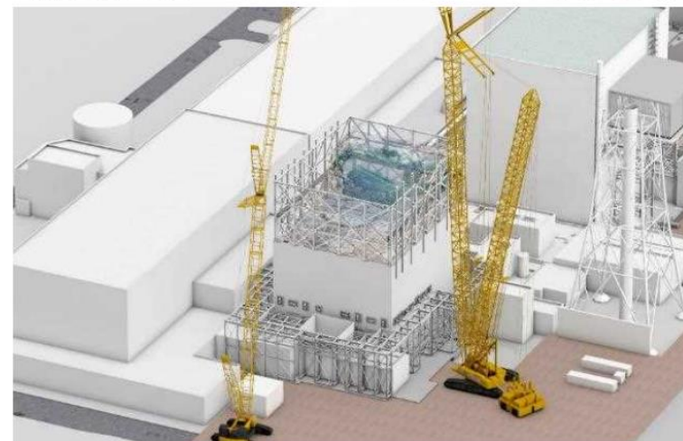
仮設構台設置完了
