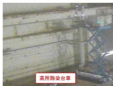
⑤高所空間／表面線量率測定状況
