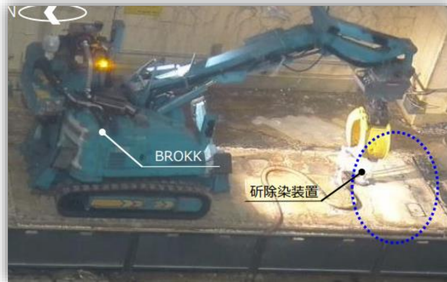
（オペフロ床面の研り除染の状況）
