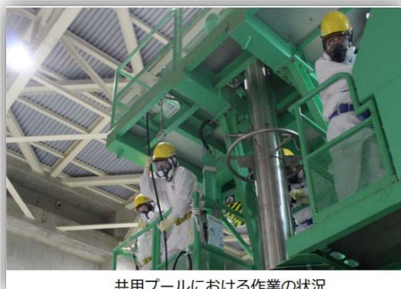
共用プールにおける作業の状況
