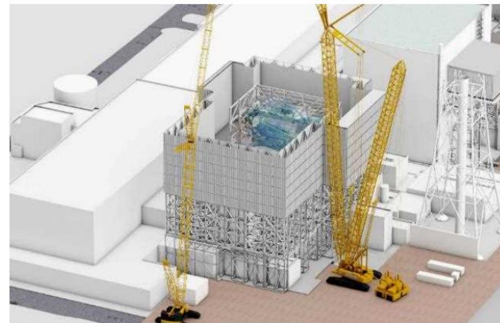
上部架構設置完了
