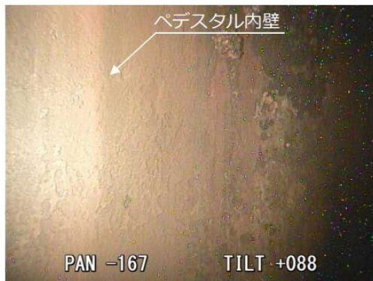
撮影場所D ペDESTAL内壁面
