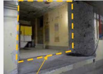
ブロックアウト部
