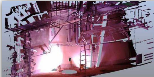
2階シェル壁東面 (点群データ)
