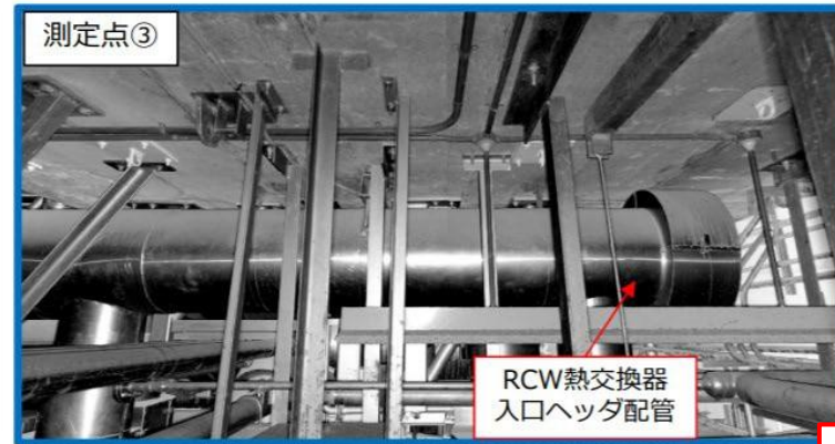
調査用穿孔部(2)から見た入口ヘッダ配管
