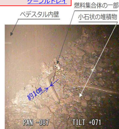
撮影場所C ペDESTAL底部
