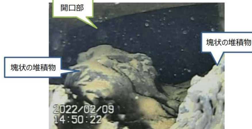
C. ペDESTAL開口部内部
