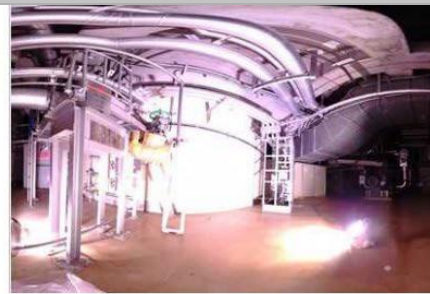
3階シェル壁北東面 (写真)
