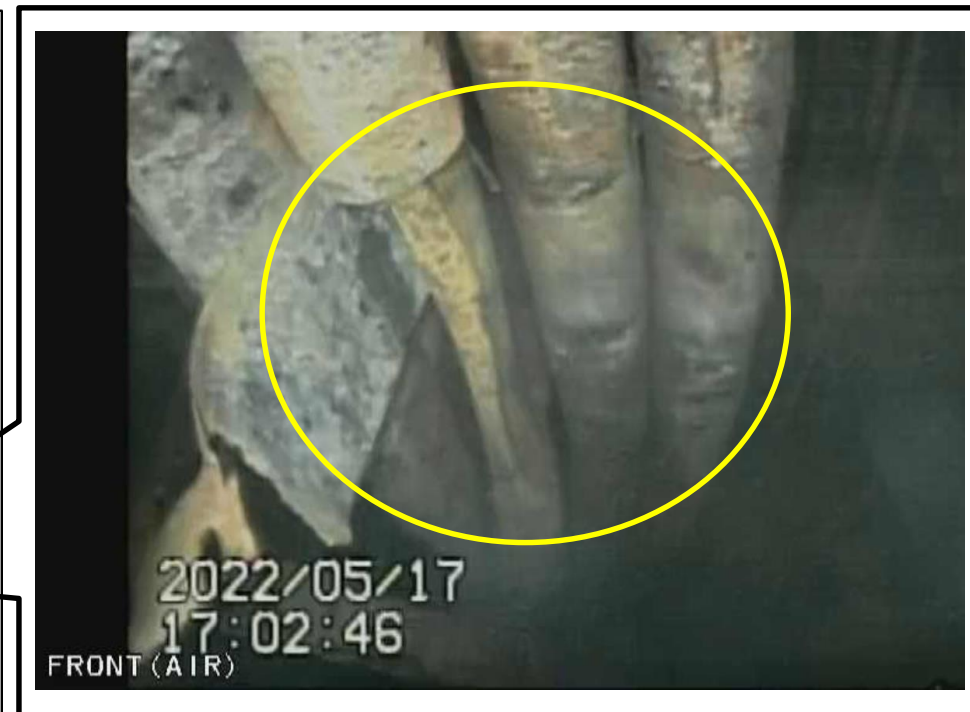
写真2. D/W内配管の状況
