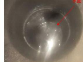
【補足】堆積物は、今後のサンプリング作業の障害になるため、サンプリングホースの敷設範囲分は取り除く(作業に支障にならない位置に寄せる)
