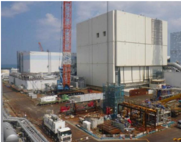
作業開始前の状況写真(2016年7月11日撮影)
