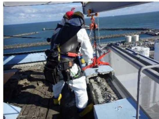
屋上での桁木撤去状況
