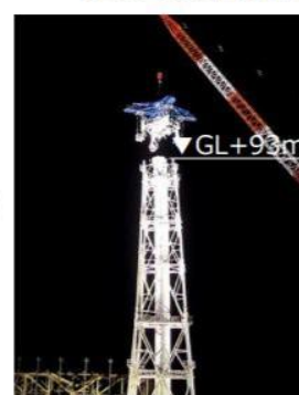
11ブロック解体時 (2020年2月1日)
