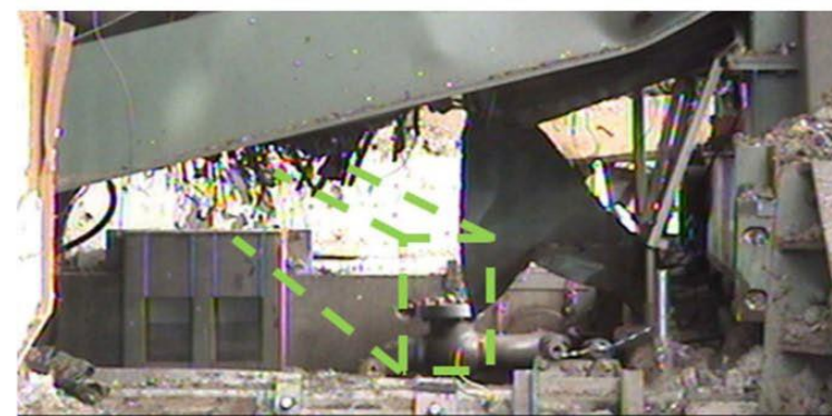
支障物撤去後写真 2020年3月14日撮影
