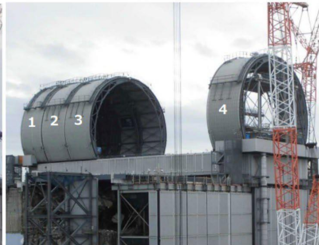
ドーム屋根設置状況 (撮影日:2017年10月25日)
