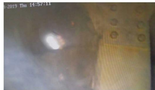
筒身内部支障物（H鋼）写真
