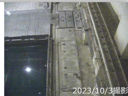
除染実施後の状況（東面）
