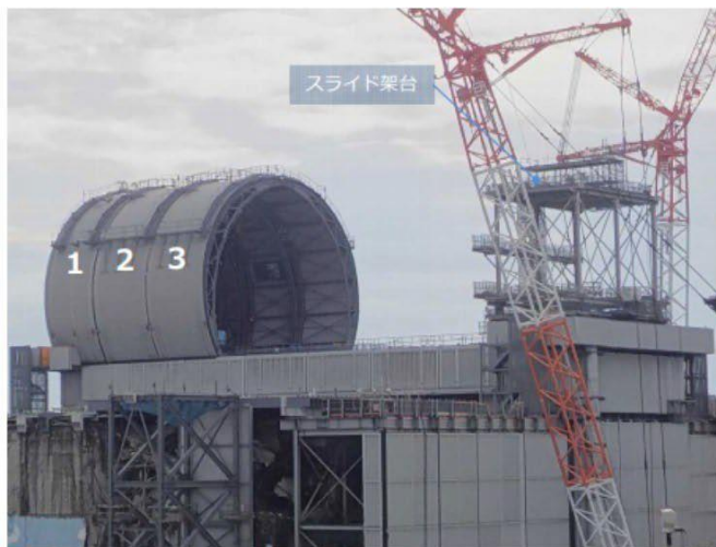
ドーム屋根設置状況 (撮影日:2017年10月17日)
