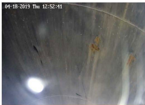
筒身内部調査の実施状況写真
