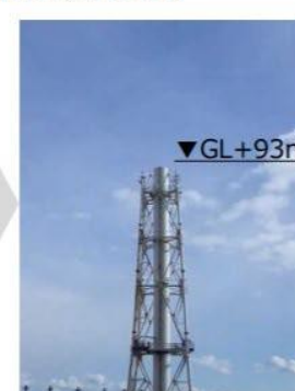
11ブロック解体後 (2020年2月4日)
