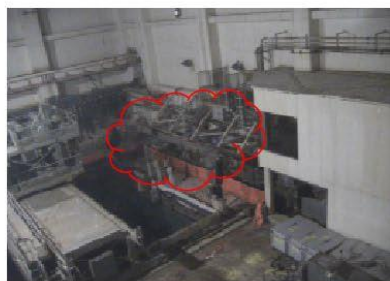
⑤干渉物撤去 (SFP南側既設設備撤去) ※4 ※4 撤去範囲と工法は検討中
