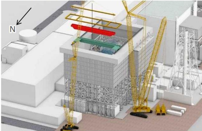
ガレキ撤去用天井クレーン設置中
