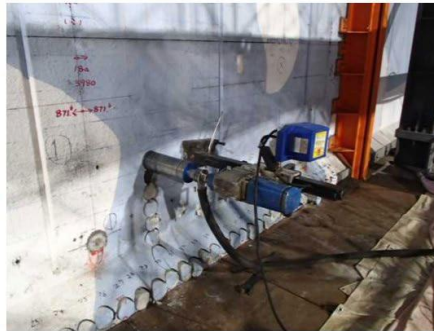
解体用コア削孔 (STEP3) 2018/4/24撮影
