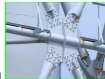
健全と判断した箇所の例
