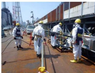
写真③ ケーブル敷設作業状況
