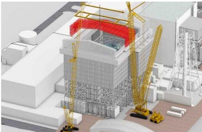
可動屋根設置中
