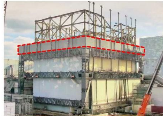
【2017年12月19日：防風フェンス取り付け完了】
