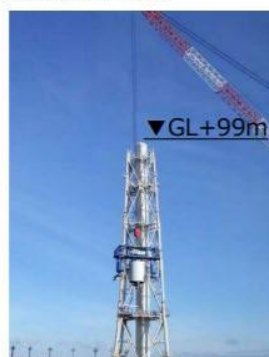
9ブロック解体後 (2020年1月17日)
