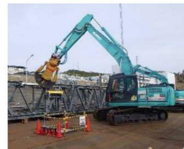
上部解体時の小割解体状況 撮影：2017.4
