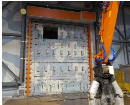
壁解体(STEP6) 2018/5/28撮影
