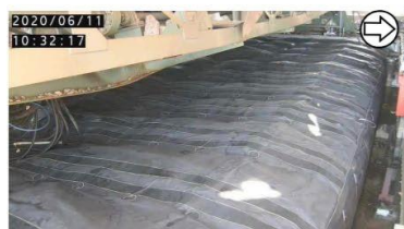
エアモルタル充填（撮影日：2020.6.11）
