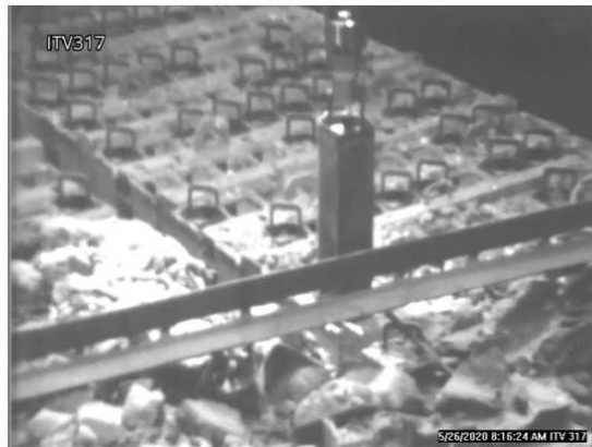
使用済み燃料のラックからの取り出し状況
