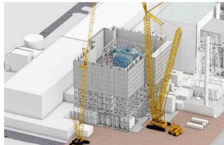
上部架構設置完了
