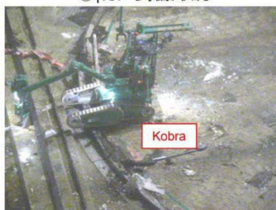
④低所表面汚染測定状況
