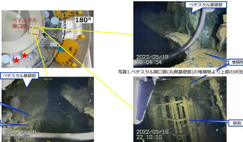
写真1.ペDESTAL開口部(右側基礎部)の堆積物より上部の状況
