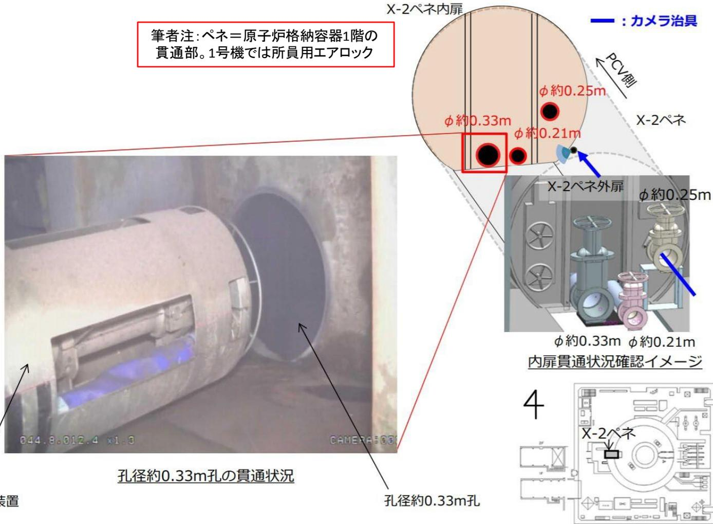
孔径約0.33m孔の貫通状況
