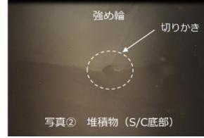
写真② 堆積物 (S/C底部)
