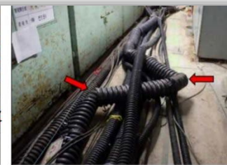
CS系SUSフレキシブルチューブの曲がりの状態
