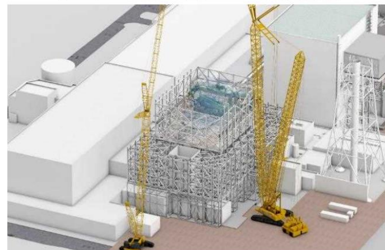
下部架構設置完了
