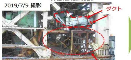
南側小ガレキ撤去前 既設架台等
