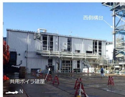
共用ボイラ建屋解体前 (2019年12月撮影)
