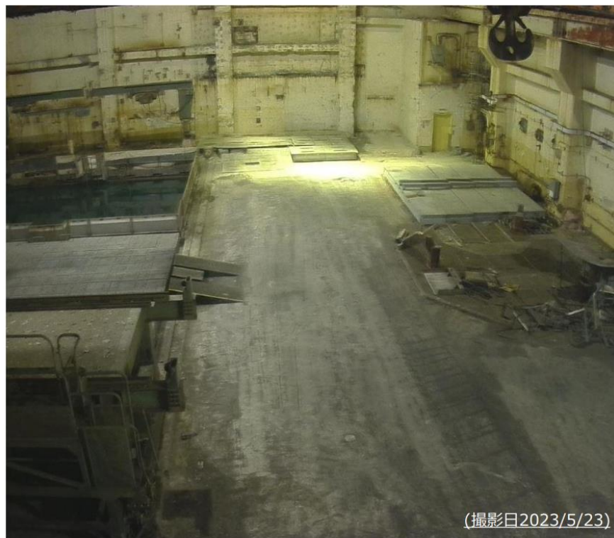
作業進捗状況
