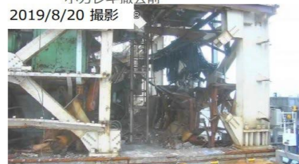
南側小ガレキ撤去後
