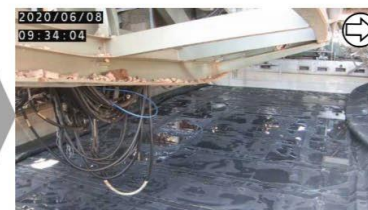
養生バッグ展張（撮影日：2020.6.8）
