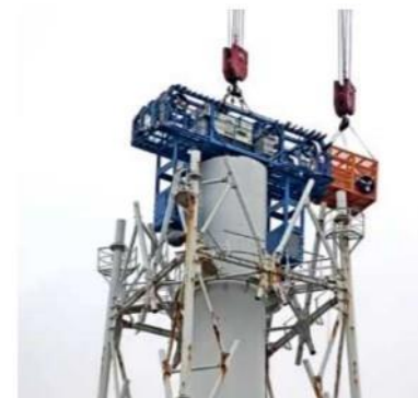
搭乗設備 作業状況
