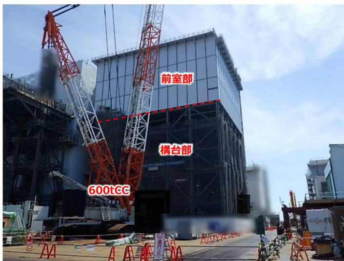
現場全景[南側] (撮影2024.6.8)
