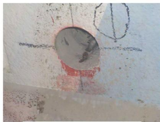
調査用コア採取の状況
