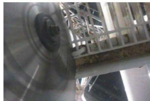
12ブロック目鉄塔解体作業(2月24日)
