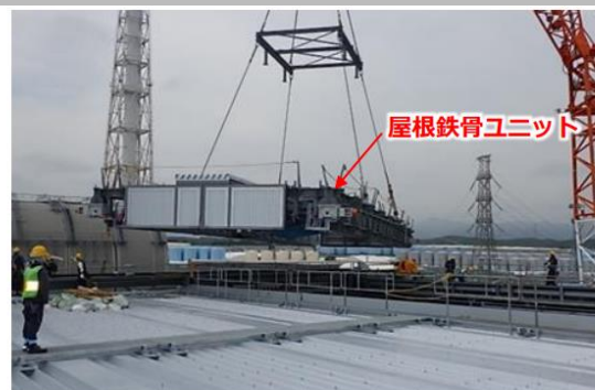
屋根鉄骨ユニット設置状況 (撮影2024.6.7)
