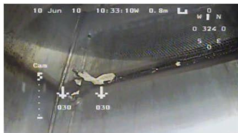
スキマサージタンク入口（北西側）正面の様子
