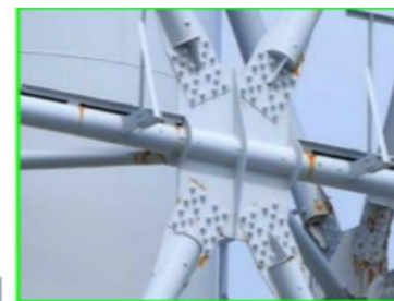
健全と判断した箇所の例
