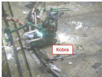
④低所表面汚染測定状況
