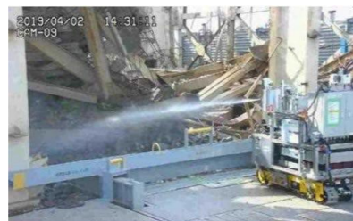
飛散防止剤散布状況
