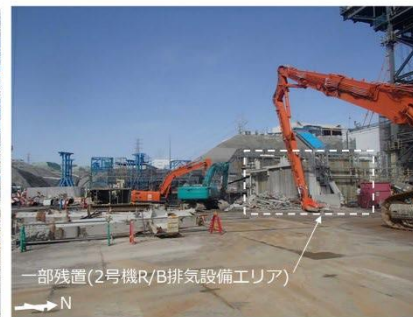
共用ボイラ建屋解体後(2020年3月撮)
