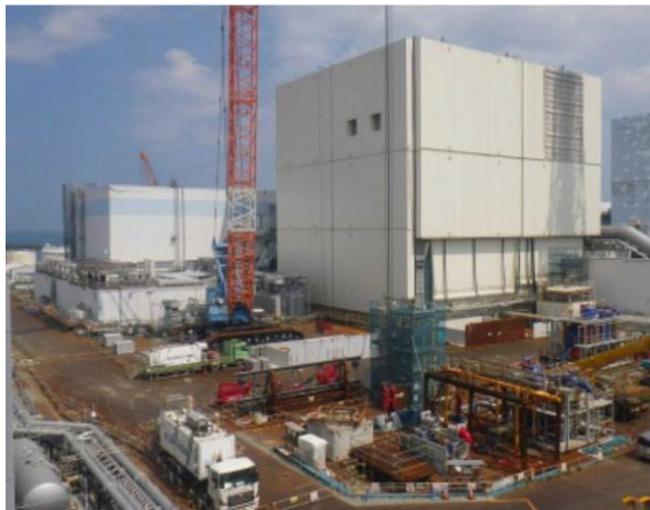
作業開始前の状況写真(2016年7月11日撮影)
