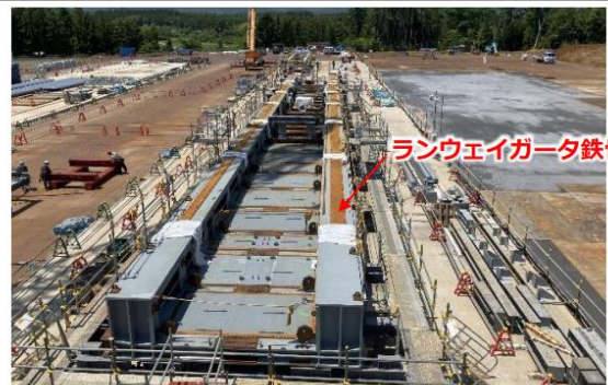
ランウェイガーダ鉄骨地組状況[構外] (撮影2024.6.8)
