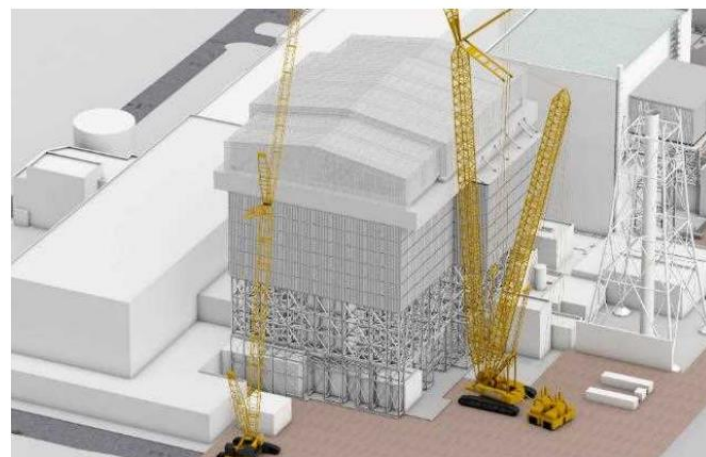
可動屋根設置完了
