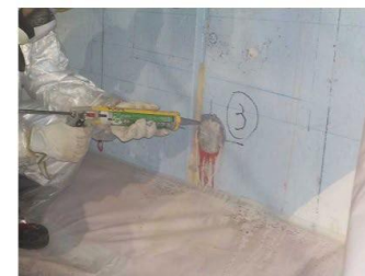
調査箇所の孔塞ぎ状況
