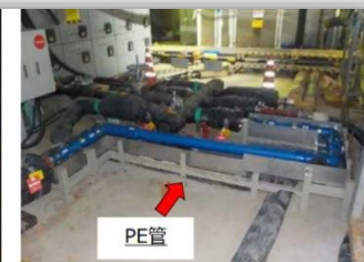
新規PE管施工後
