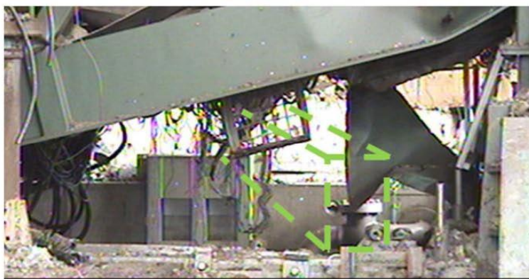
支障物撤去前写真 2020年3月9日撮影
