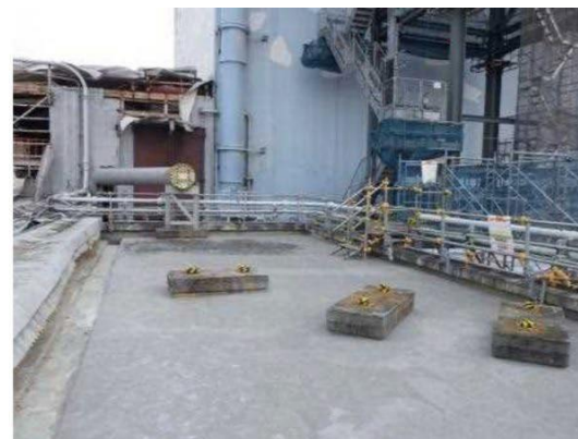
FSTR建屋片付け状況
