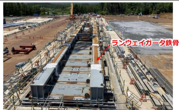
ランウェイガーダ鉄骨地組状況[構外] (撮影2024.6.8)
