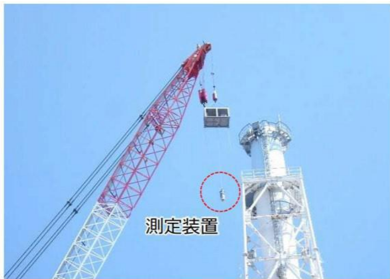
解体前調査の実施状況
