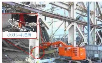
遠隔操作重機による作業状況
