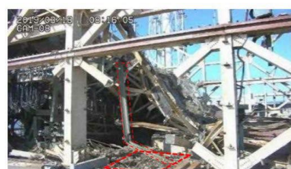
小ガレキ撤去前
