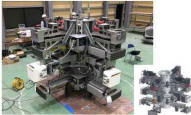
筒身解体装置 組立状況
