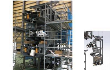
鉄塔解体装置（斜材用）組立状況
