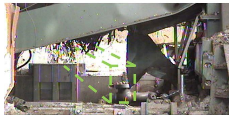
支障物撤去後写真 2020年3月14日撮影
