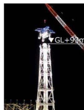
11ブロック解体時 (2020年2月1日)
