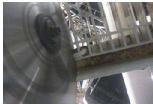
12ブロック目鉄塔解体作業(2月24日)
