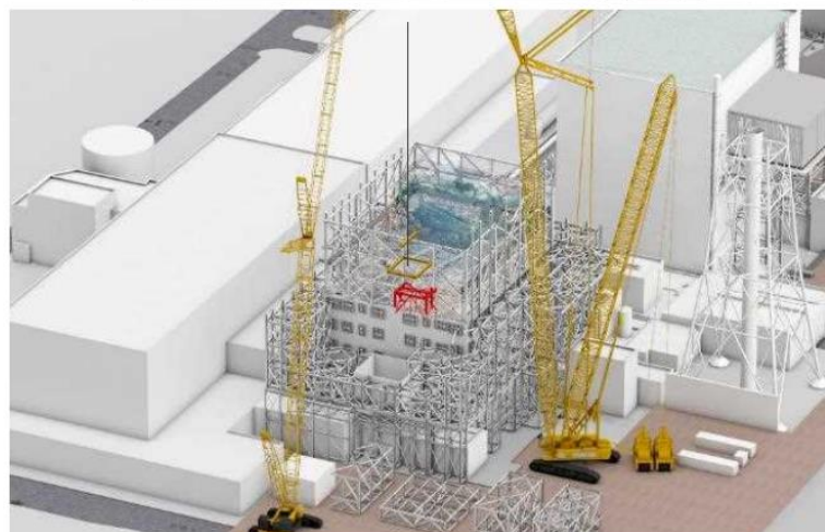
下部架構設置中
