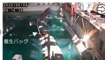
養生バッグ投入 (撮影日: 2020.6.8)
