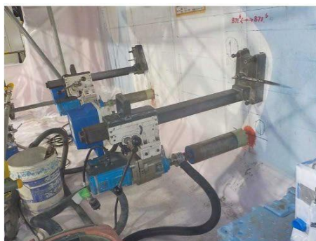
コア削孔装置設置状況
