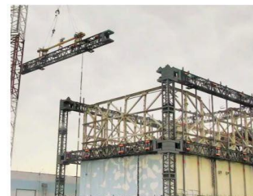
上部解体時の梁取り外し状況 撮影：2017.7
