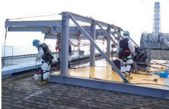
架台設置状況（原子炉建屋屋上）
