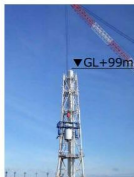
9ブロック解体後 (2020年1月17日)
