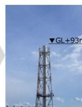
11ブロック解体後 (2020年2月4日)
