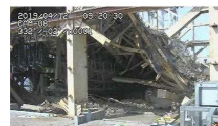
小ガレキ撤去状況
