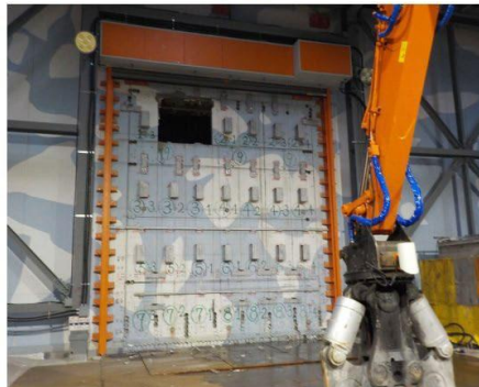
壁解体(STEP6) 2018/5/28撮影
