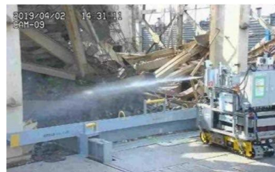
飛散防止剤散布状況
