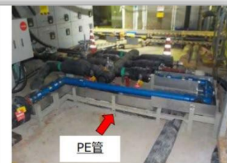
新規PE管施工後
