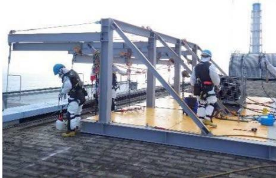
架台設置状況（原子炉建屋屋上）
