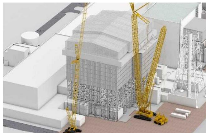
可動屋根設置完了
