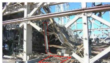
小ガレキ撤去前
