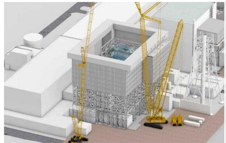
ボックスリング設置完了
