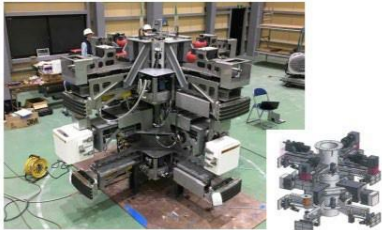
筒身解体装置 組立状況
