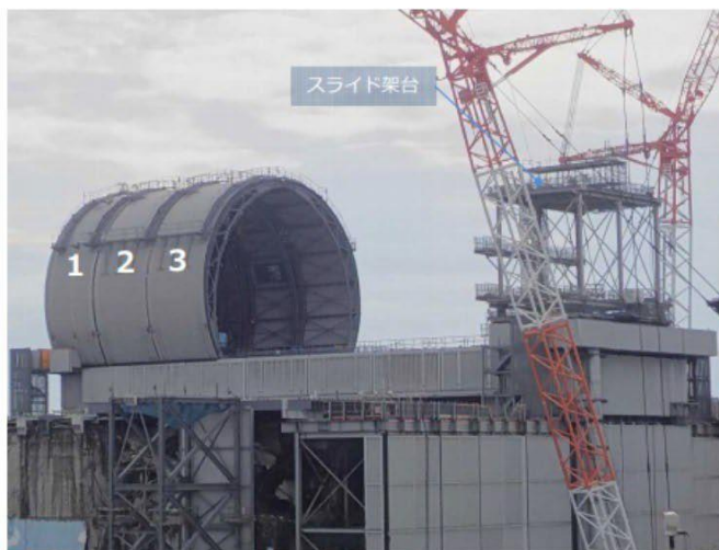
ドーム屋根設置状況 (撮影日:2017年10月17日)
