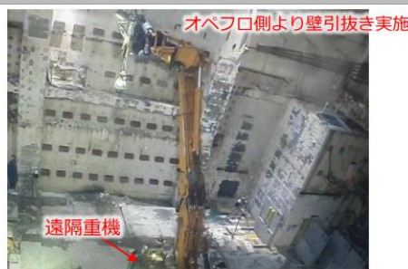
写真②: 壁引抜き作業状況
