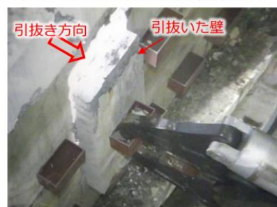
写真③: 壁引抜き作業状況
