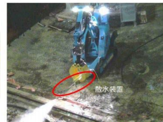
① 散水状況 (ダスト抑制対策)
