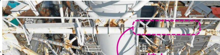
【写真①】 地上約76mの南側水平材
