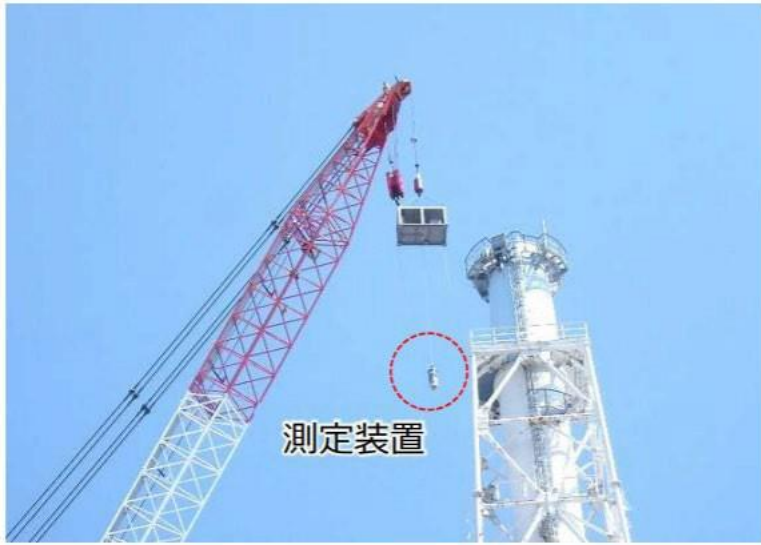
解体前調査の実施状況
