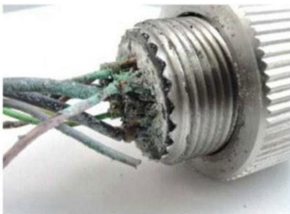
①接続部外観
