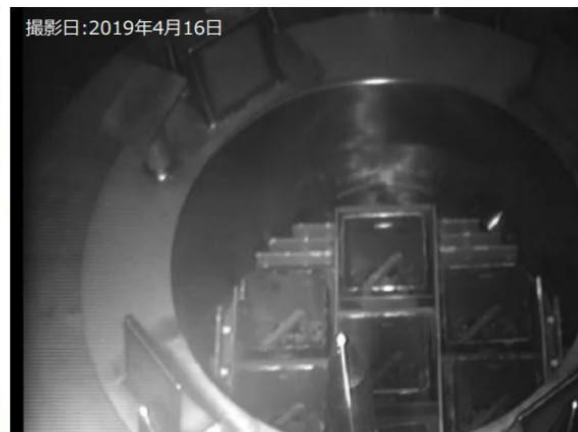
輸送容器へ燃料装填完了(7体)
