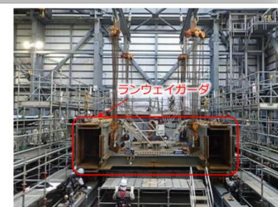
ランウェイガーダ鉄骨ブロックの設置状況 (撮影2024.10.24)
