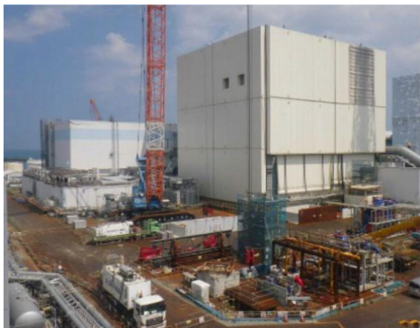
作業開始前の状況写真(2016年7月11日撮影)
