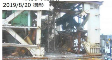
南側小ガレキ撤去後
