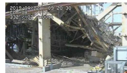
小ガレキ撤去状況
