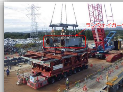
ランウェイガーダ鉄骨ブロックの積込状況 (撮影2024.10.23)
