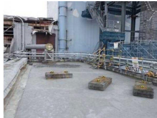
FSTR建屋片付け状況
