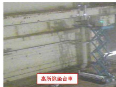
⑤高所空間／表面線量率測定状況
