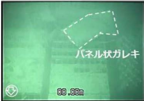
写真① (水中1m 斜め下方向)
