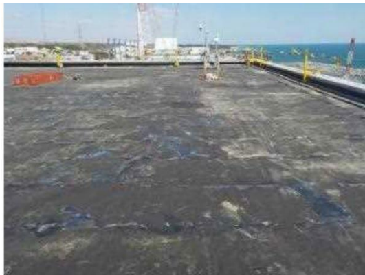
2R/B上屋対策状況
