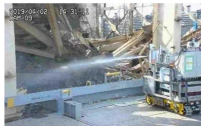
飛散防止剤散布状況
