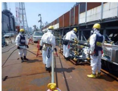
写真③ ケーブル敷設作業状況
