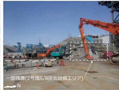
共用ボイラ建屋解体後(2020年3月撮)
