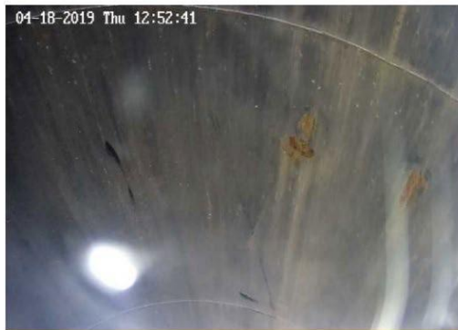
筒身内部調査の実施状況写真
