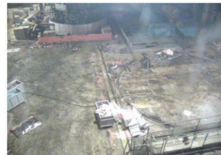
② 残置物片付後 (北側) 撮影日(10/22)
