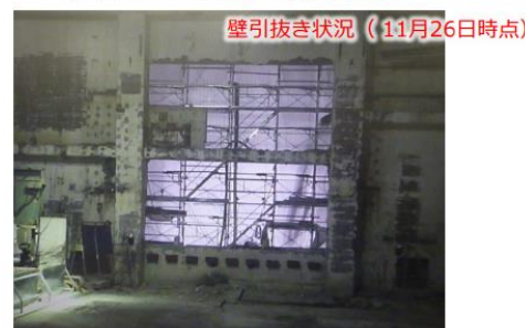
写真④: 壁引抜き作業状況
