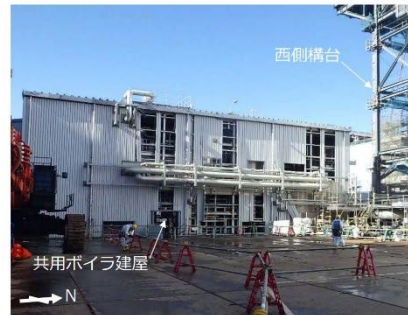
共用ボイラ建屋解体前 (2019年12月撮影)
