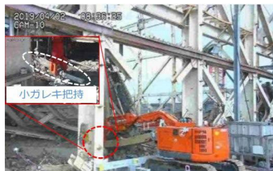
遠隔操作重機による作業状況
