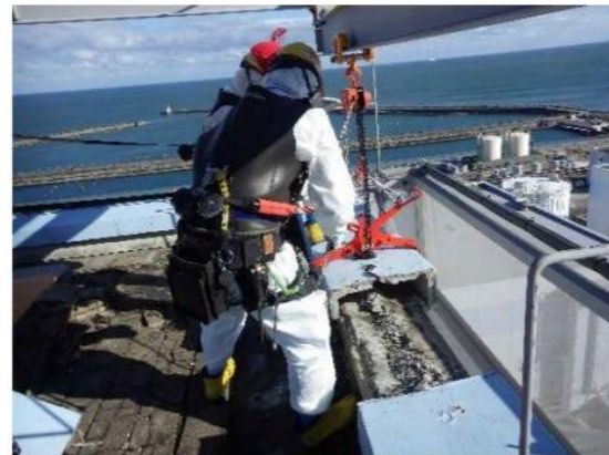
屋上での笠木撤去状況
