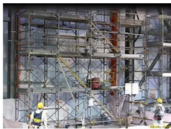
調査用コア採取の作業状況(全景)
