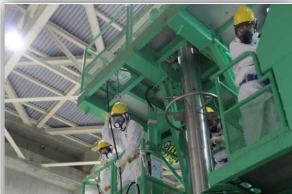
共用プールにおける作業の状況
