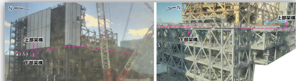
現場状況 (北西面) (撮影: 12月24日)
