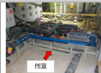
新規PE管施工後
