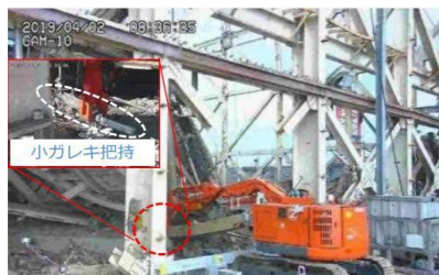
遠隔操作重機による作業状況
