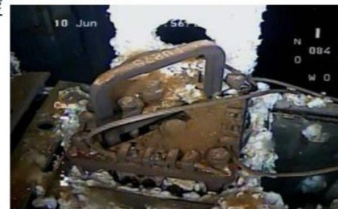
ワイヤー修復燃料上部の様子
