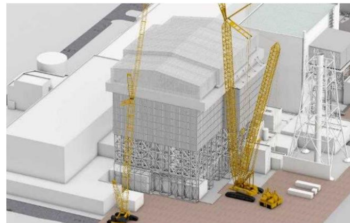
可動屋根設置完了
