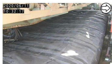
エアモルタル充填 (撮影日: 2020.6.11)
