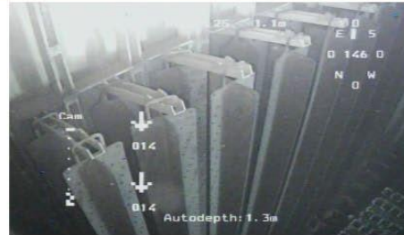
制御棒ハンガー（北東側）の様子
