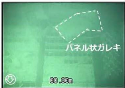
写真① (水中1m 斜め下方向)
