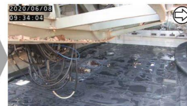
養生バッグ展張 (撮影日: 2020.6.8)
