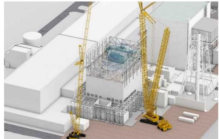
仮設構台設置完了
