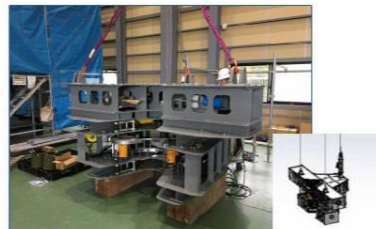
鉄塔解体装置（支柱材用）組立状況
