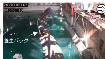
養生バッグ投入 (撮影日: 2020.6.8)
