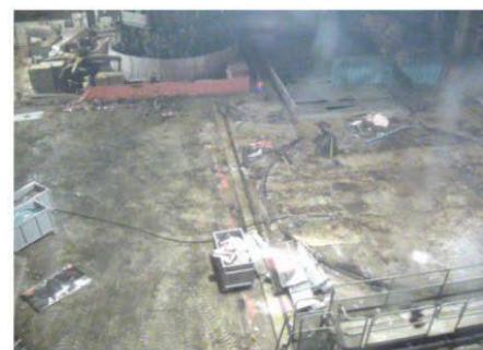
② 残置物片付後 (北側) 撮影日(10/22)
