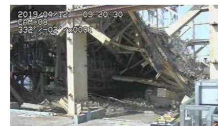
小ガレキ撤去状況
