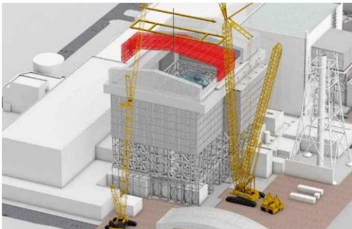
可動屋根設置中
