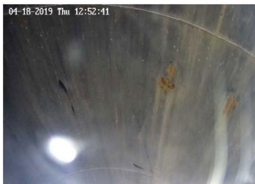
筒身内部調査の実施状況写真
