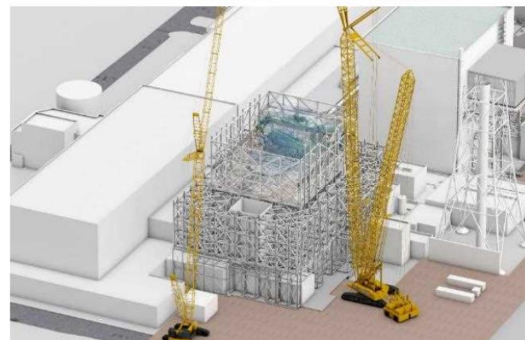
下部架構設置完了
