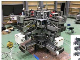
筒身解体装置 組立状況
