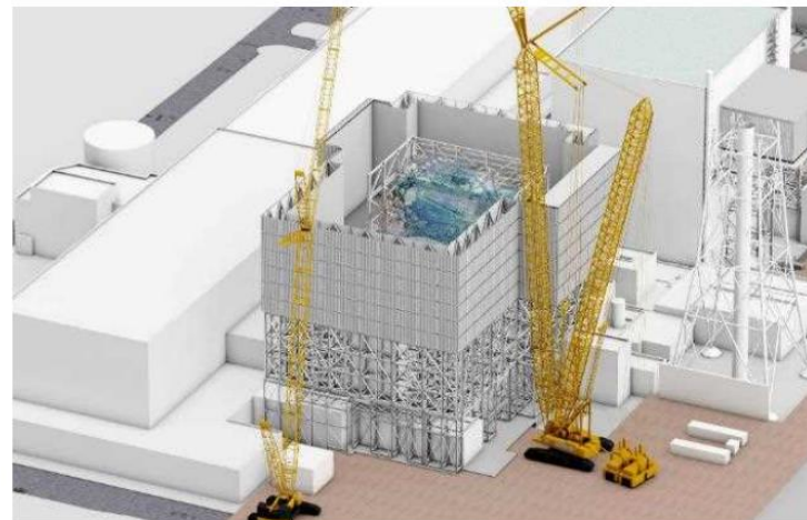
上部架構設置完了
