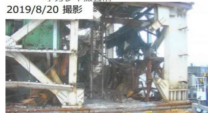
南側小ガレキ撤去後
