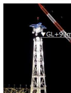
11ブロック解体時 (2020年2月1日)
