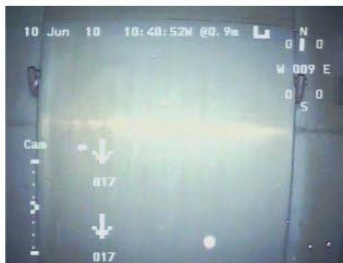
プールゲート正面の様子
