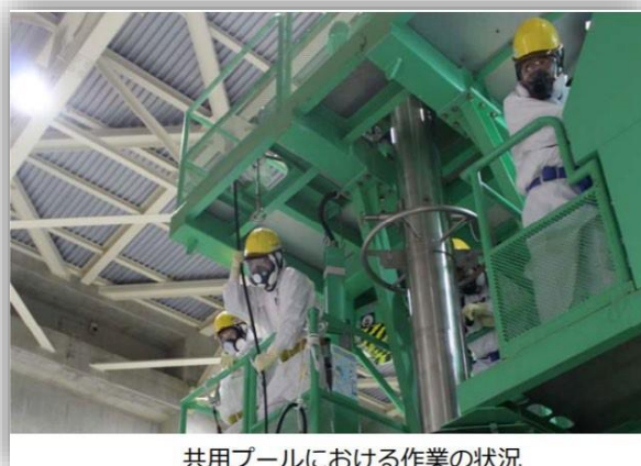
共用プールにおける作業の状況
