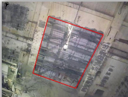
写真①：ランウェイガーダ用開口設置状況 (撮影日：2024.12.6) R/B オペフロ側より撮影
