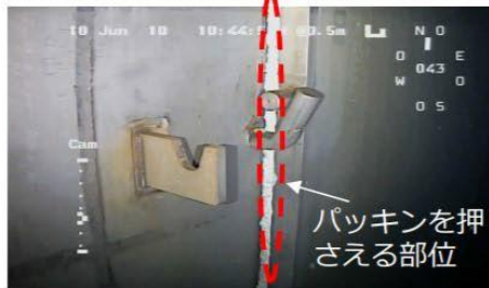
プールゲート支持軸の様子
