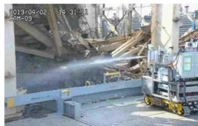
飛散防止剤散布状況
