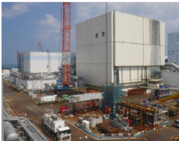
作業開始前の状況写真(2016年7月11日撮影)
