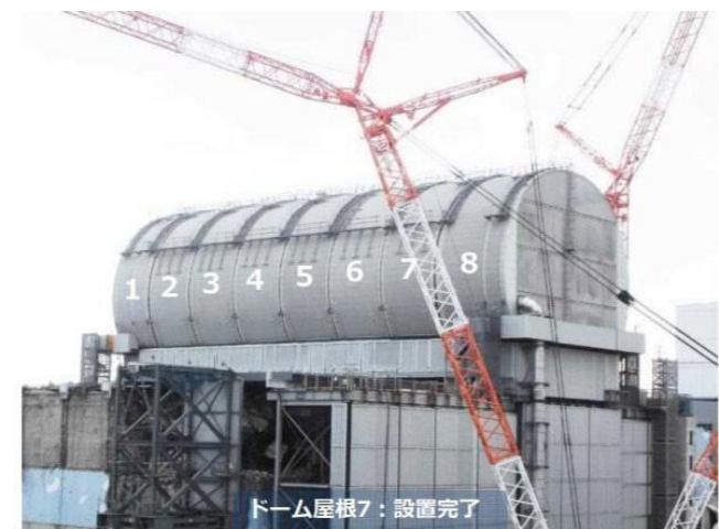
ドーム屋根7設置完了 (撮影日2018年2月28日)
