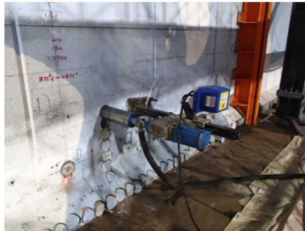
解体用コア削孔 (STEP3) 2018/4/24撮影
