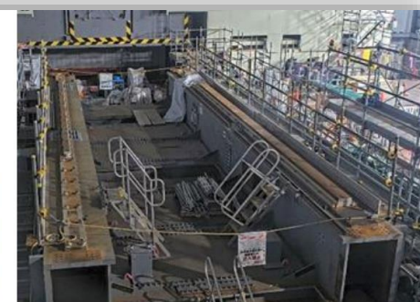
ランウェイガーダ鉄骨の設置状況 (撮影2024.12.13)
