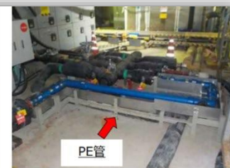
新規PE管施工後
