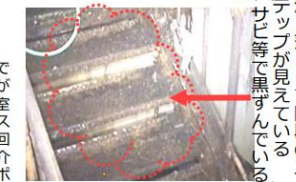
階段室内の作業状況（作業後）
