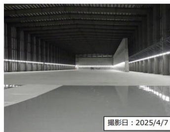
10-C棟の内部
