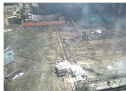
②残置物片付後（北側）撮影日(10/22)
