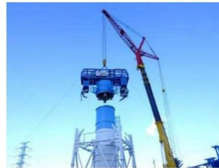
実証試験実施状況（2018.9.28）
