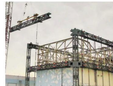
上部解体時の梁取り外し状況 撮影：2017.7
