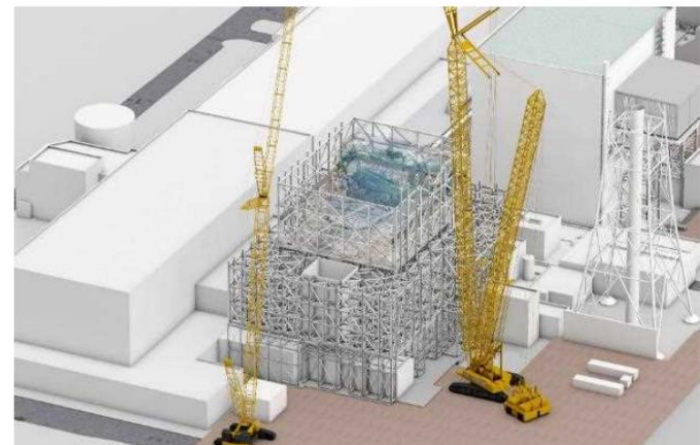
下部架構設置完了
