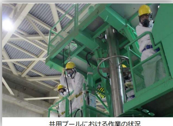
共用プールにおける作業の状況
