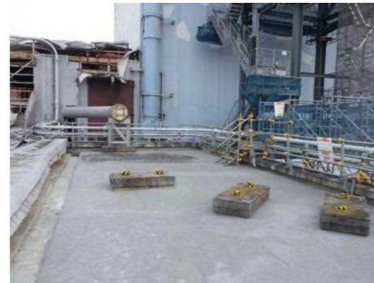
FSTR建屋片付け状況
