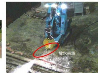
① 散水状況 (ダスト抑制対策)
