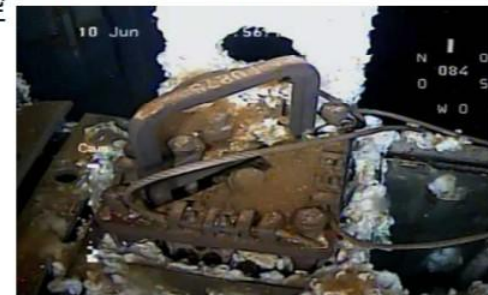
ワイヤー修復燃料上部の様子
