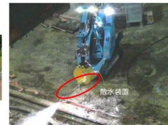
① 散水状況 (ダスト抑制対策)
