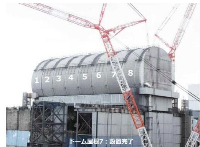
ドーム屋根7設置完了 (撮影日2018年2月28日)
