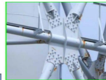
健全と判断した箇所の例
