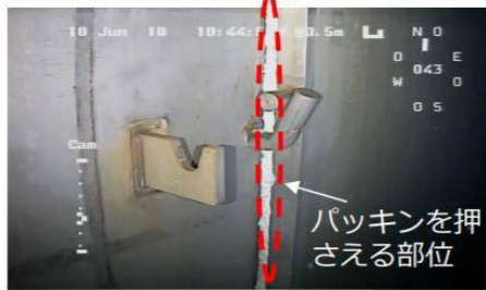
プールゲート支持軸の様子
