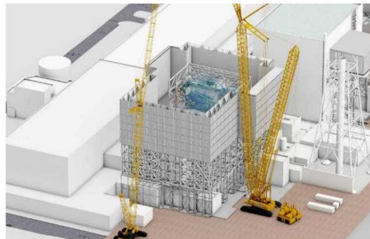
上部架構設置完了
