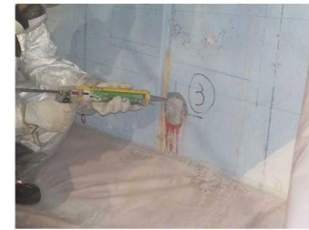
調査箇所の孔塞ぎ状況
