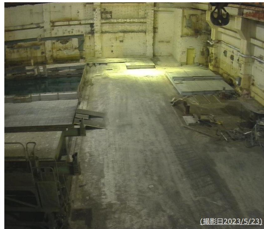
作業進捗状況
