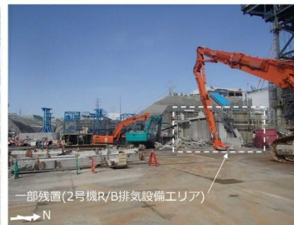
共用ボイラ建屋解体後(2020年3月撮影)
