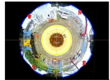
装置据付け時のカメラ画像
