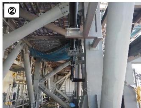
代替注水ライン設置状況 (撮影：2月26日)
