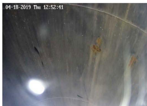
筒身内部調査の実施状況写真
