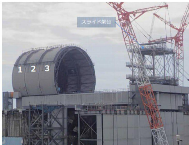
ドーム屋根設置状況 (撮影日:2017年10月17日)
