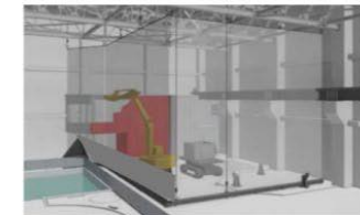
④干渉物撤去 (FHM操作室撤去) ※3
