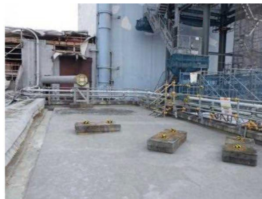
FSTR建屋片付け状況
