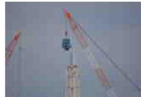
<頂部ブロック吊り下げ>
