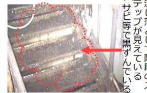
階段室内の作業状況（作業後）
