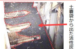
階段室内の作業状況（作業前）
