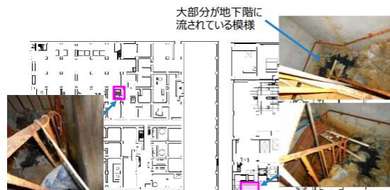
(写真：PMB 1階 階段室)
