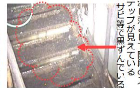
階段室内の作業状況（作業後）
