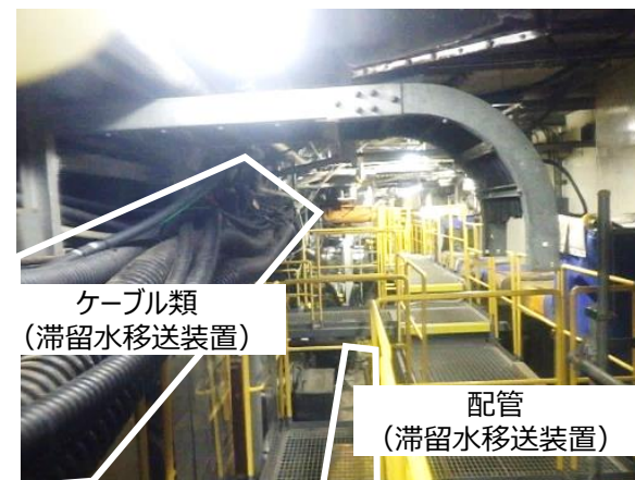
3号機廃棄物処理建屋内部
