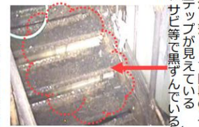
階段室内の作業状況（作業後）
