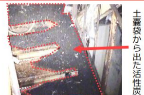
階段室内の作業状況（作業前）
